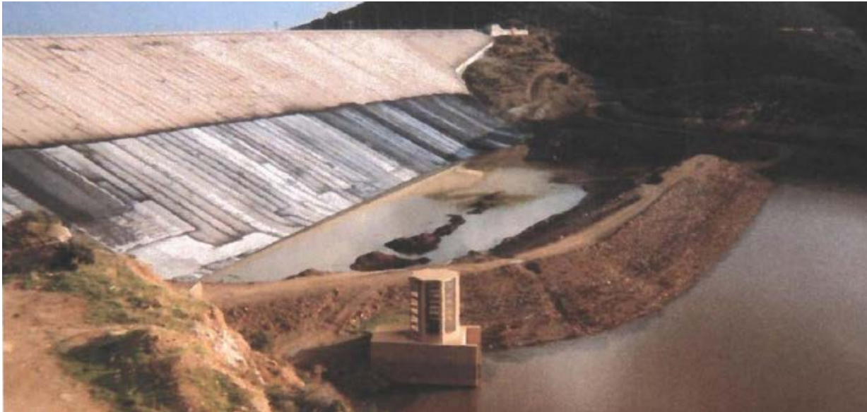
Figura 4.2.1 Avandiga durante la fase di costruzione
