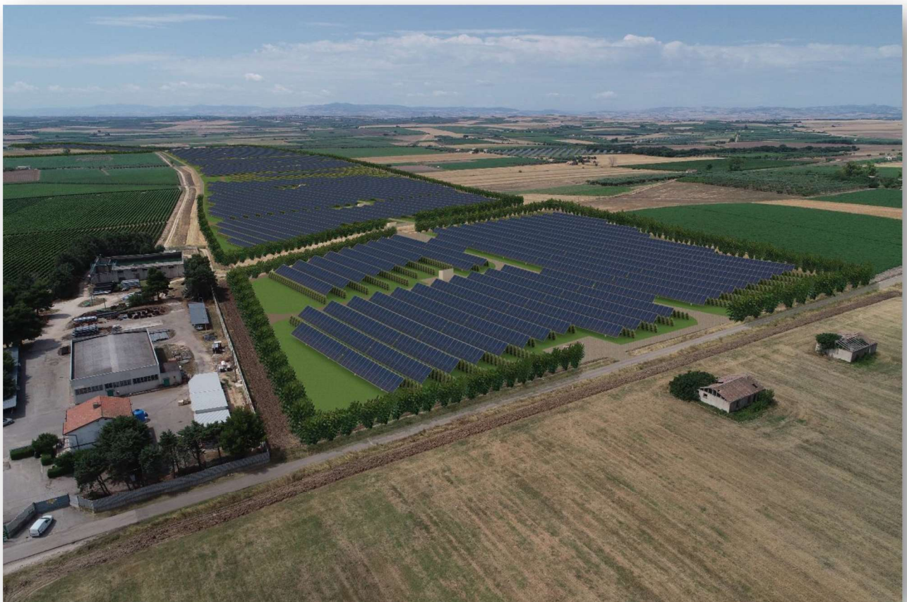
Figura 28 - Vista panoramica da nord
