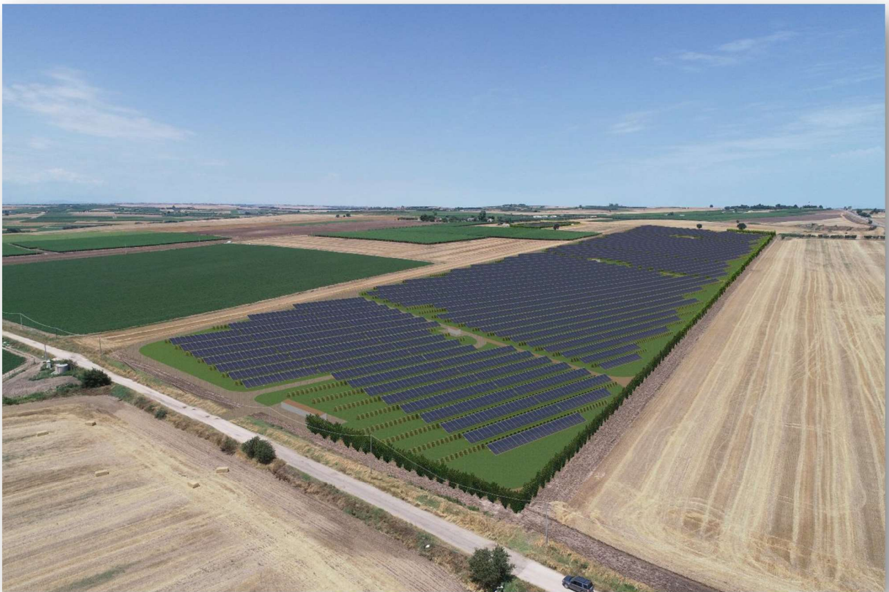
Figura 28 - Vista panoramica da sud
