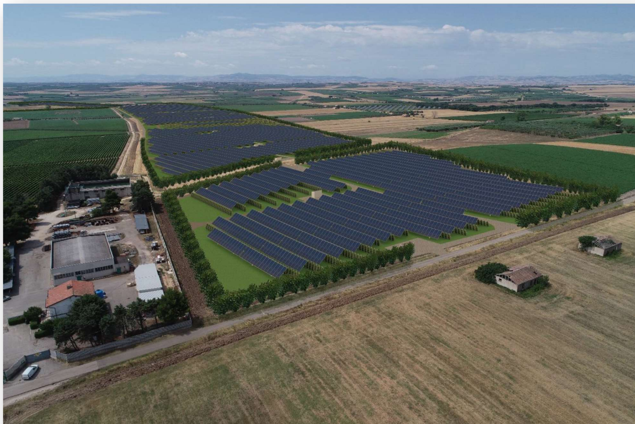
Figura 29 - Vista panoramica da nord
