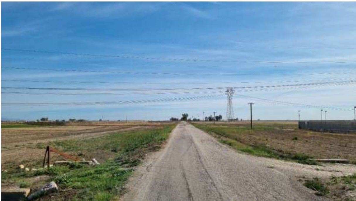
Vista del sito destinato all'impianto agrovoltaico rispetto all'impianto ETA
