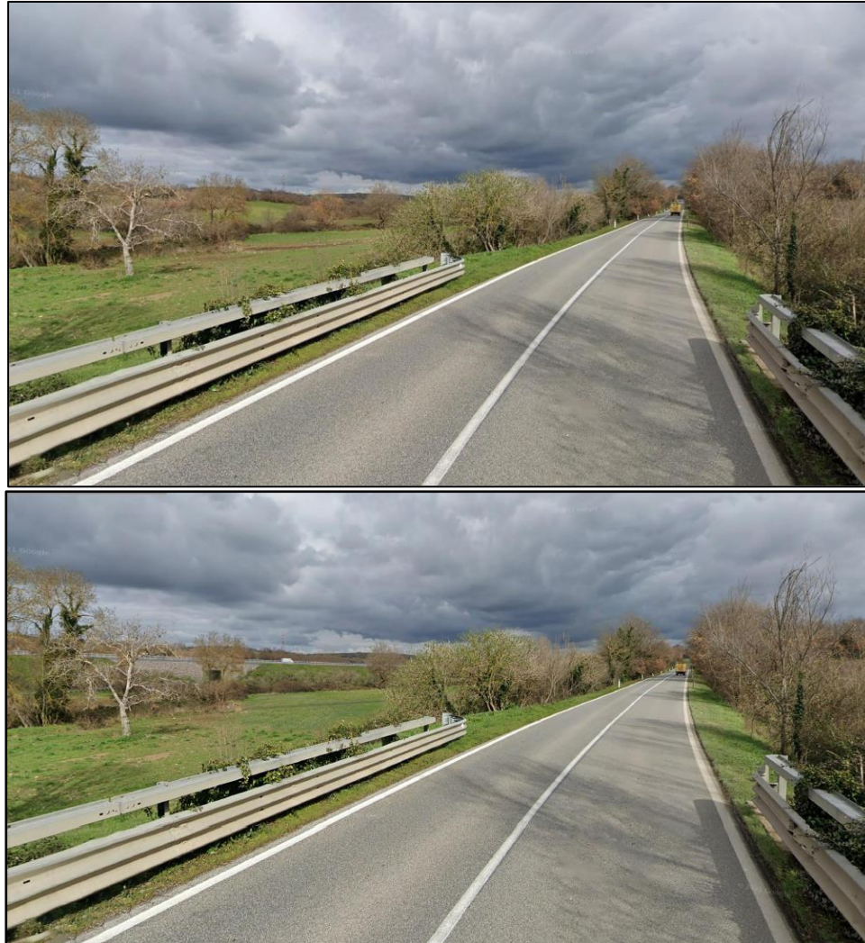
Figura 4-18 Confronto visuale ante operam lungo la SS1Bis e sotto visuale post operam lungo la SS1Bis (è visibile a sinistra il nuovo tracciato in rilevato della SS675 dopo intersezione SS1Bis), in direzione imbocco est della galleria Monte Romano
