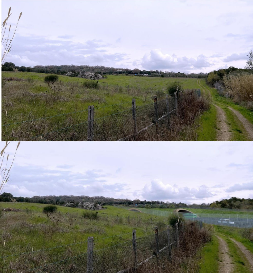
Figura 4-20 Confronto visuale ante operam lungo la VM03 verso poggio Ficonaccia e sotto visuale post mitigata lungo la VM03 verso l'imbocco ovest della galleria Monte Romano (è visibile la conformazione ondulata dei terreni agricoli attraversati)
