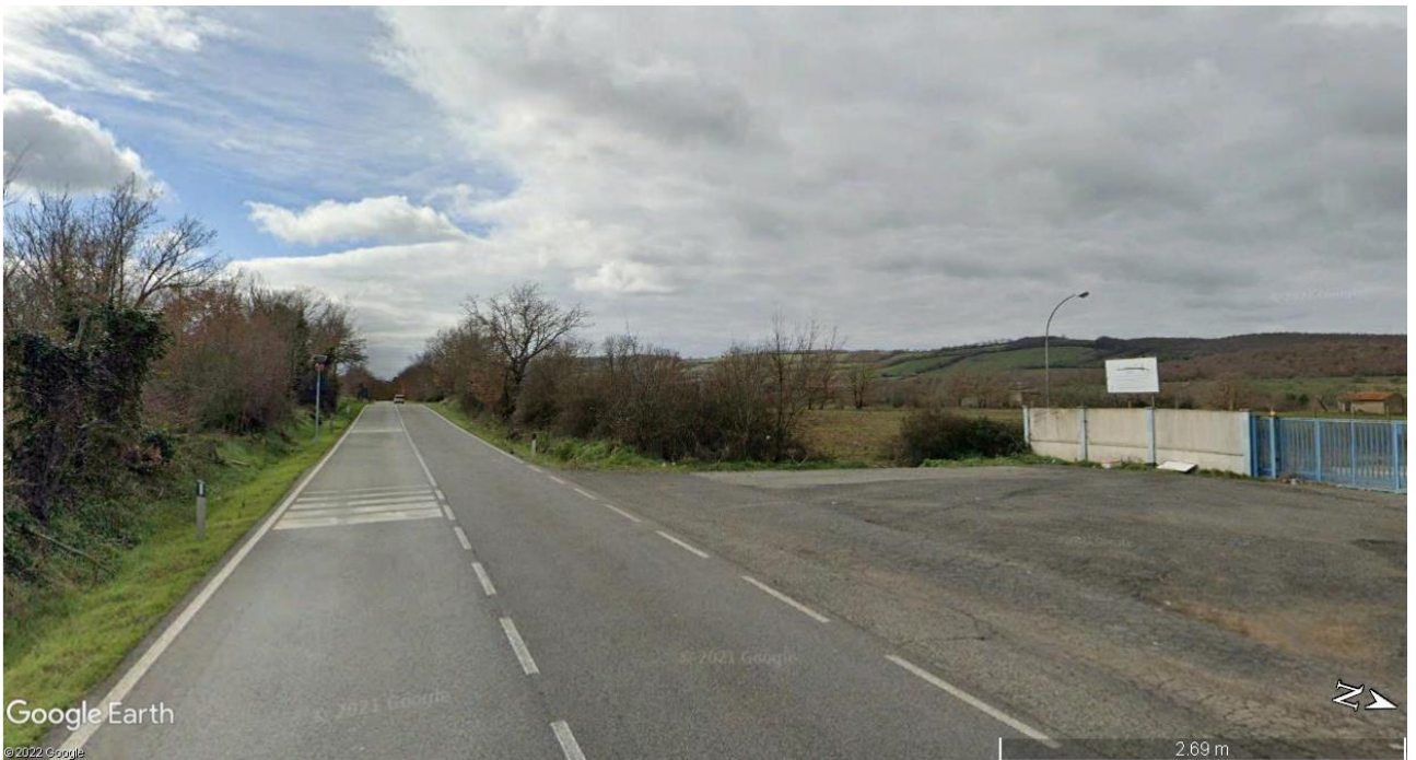
Figura 4-13 VISTA 1 - Tratto est tracciato su SS1Bis in direzione Monte Romano – il nuovo tracciato si dirige a nord di Monte Romano verso Poggio Ficonaccia dove verrà realizzata la nuova galleria – la freccia indica l'andamento del nuovo asse stradale
