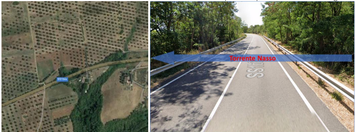
Figura 1-7 Attraversamento torrente Nasso
