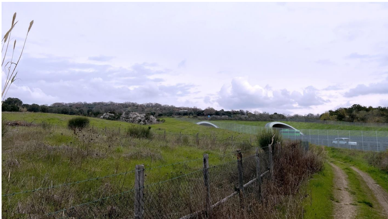
Figura 6-9- Confronto visuale ante operam lungo la VM03 verso poggio Ficonaccia e sotto visuale post operam lungo la VM03 verso l'imbocco ovest della galleria Monte Romano (è visibile la conformazione ondulata dei terreni agricoli attraversati)
