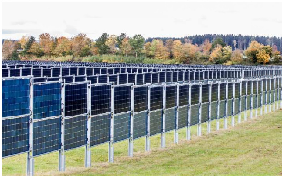
Figura 1: Particolari costruttivi struttura sostegno moduli - Agrovoltaiico
