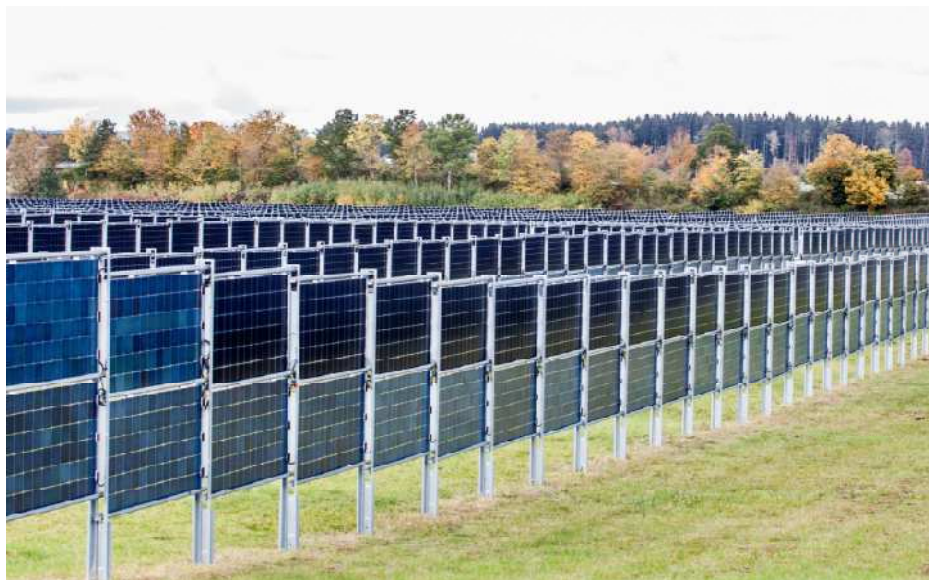
Esempio di struttura realizzata
