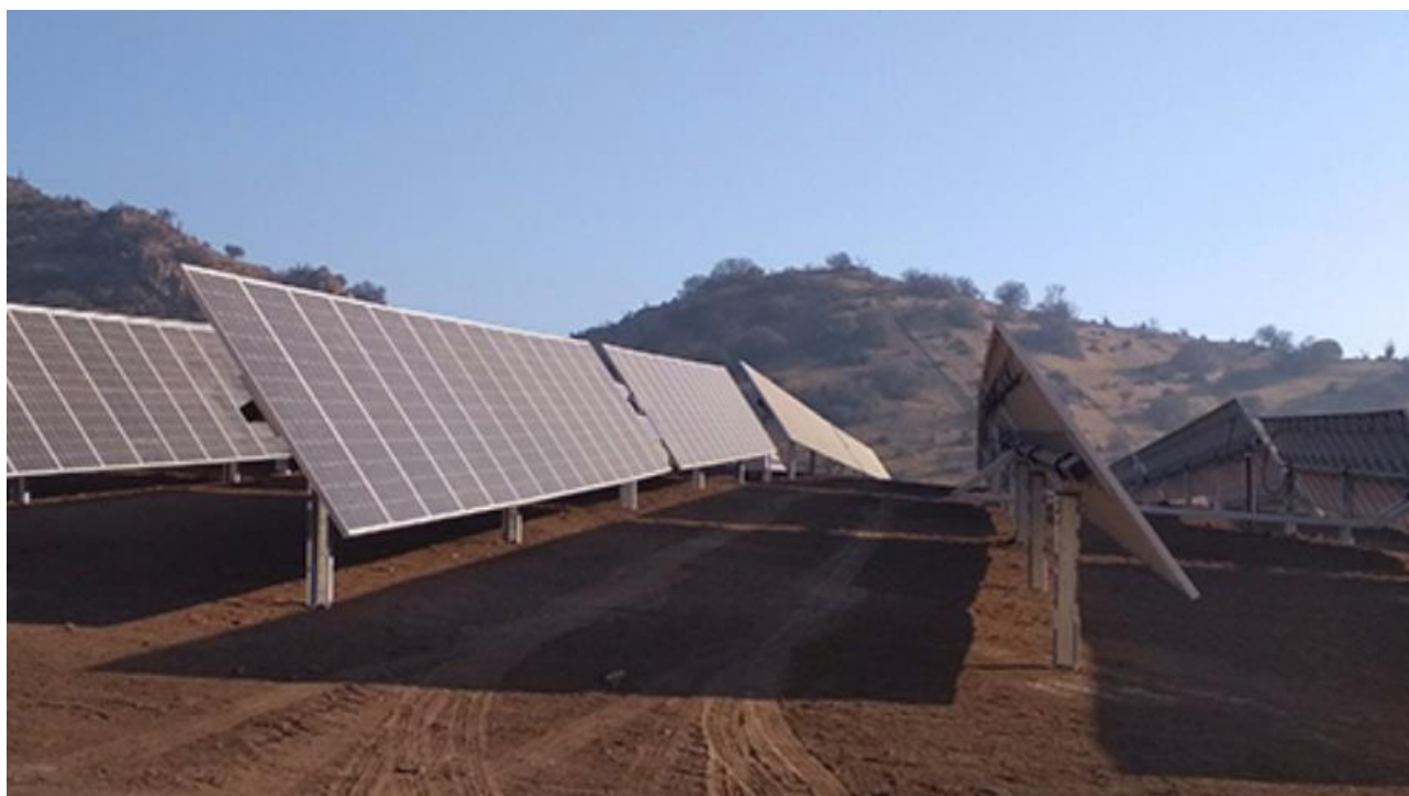
Figura 1 - immagine esemplificativa di inseguitori mono-assiali STI-H250 in configurazione 1P (fonte: STI Norland)
