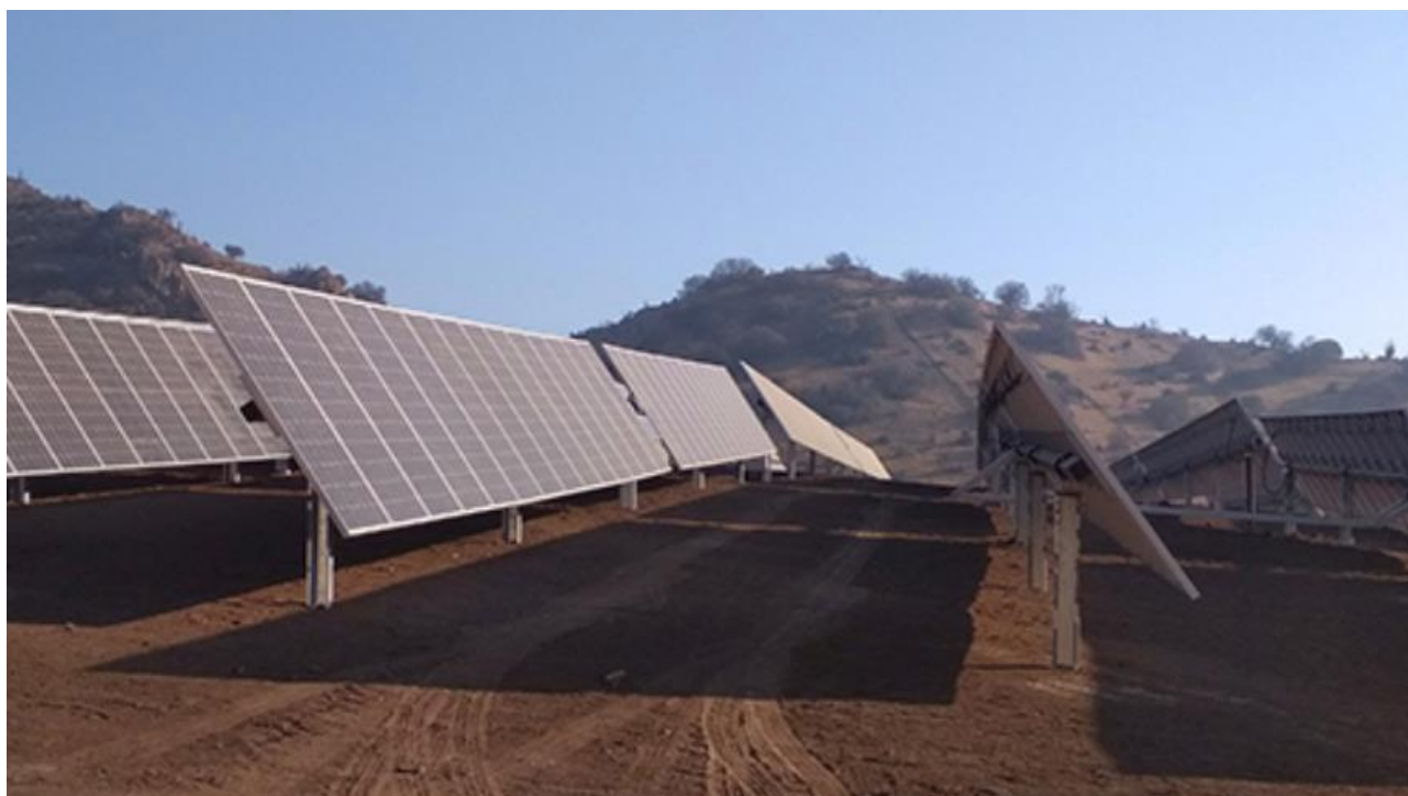
Figura 6 - immagine esemplificativa di inseguitori mono-assiali STI-H250 in configurazione 1P (fonte: STI Norland)
