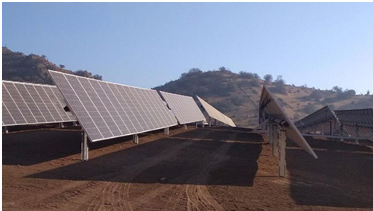
Figura 2 - immagine esemplificativa di inseguitori mono-assiali STI-H250 in configurazione 1P (fonte: STI Norland)
