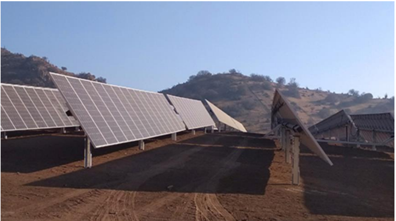
Figura 3 - immagine esemplificativa di inseguitori mono-assiali STI-H250 in configurazione 1P (fonte: STI Norland)
