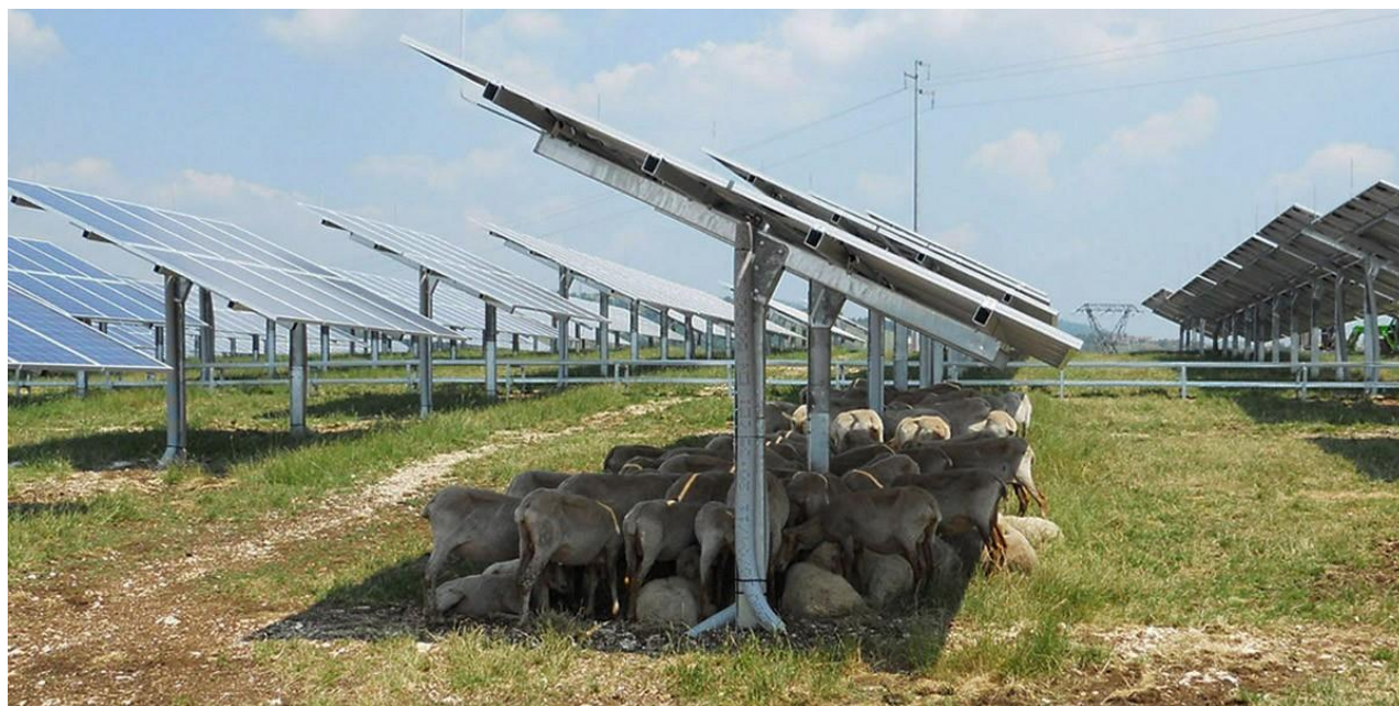
Fig. 17. Prato-pascolo aree poste sotto i pannelli
