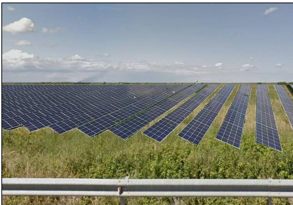
Foto 4A – Vista verso nord dalla strada a valenza paesaggistica “SS Salentina” (cerchio colore rosso in Figura 29). STATO DI PROGETTO SENZA MITIGAZIONE VEGETAZIONALE
