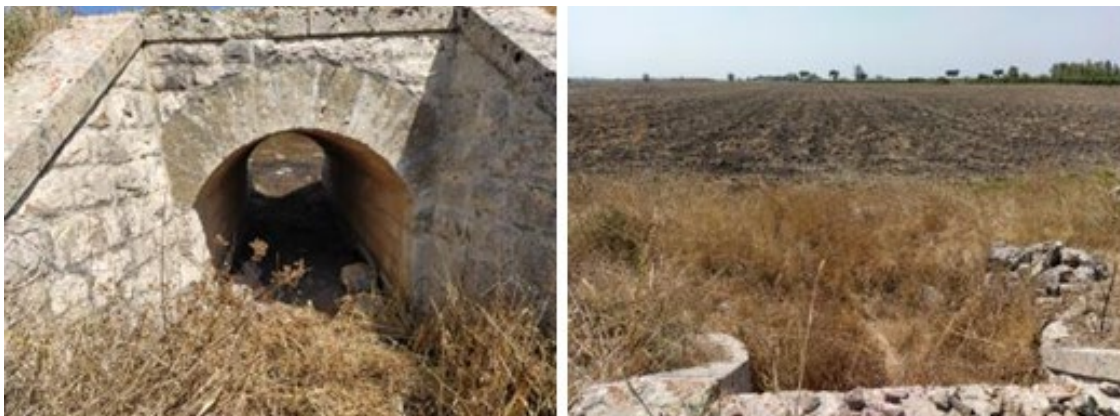
Figura 13 - Reticolo 2: Attraversamento ferroviario 1
