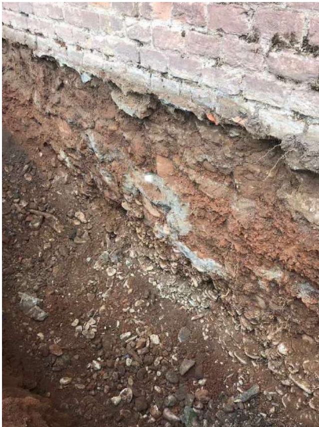
SCAVI GEOGNOSTICI CASCINA PONZANA
