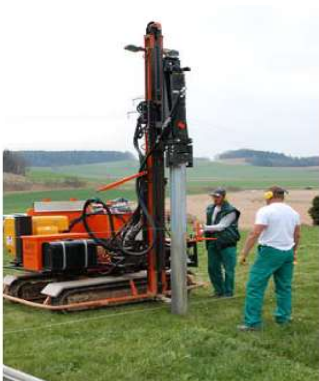
Figura 13 - Particolare di installazione
