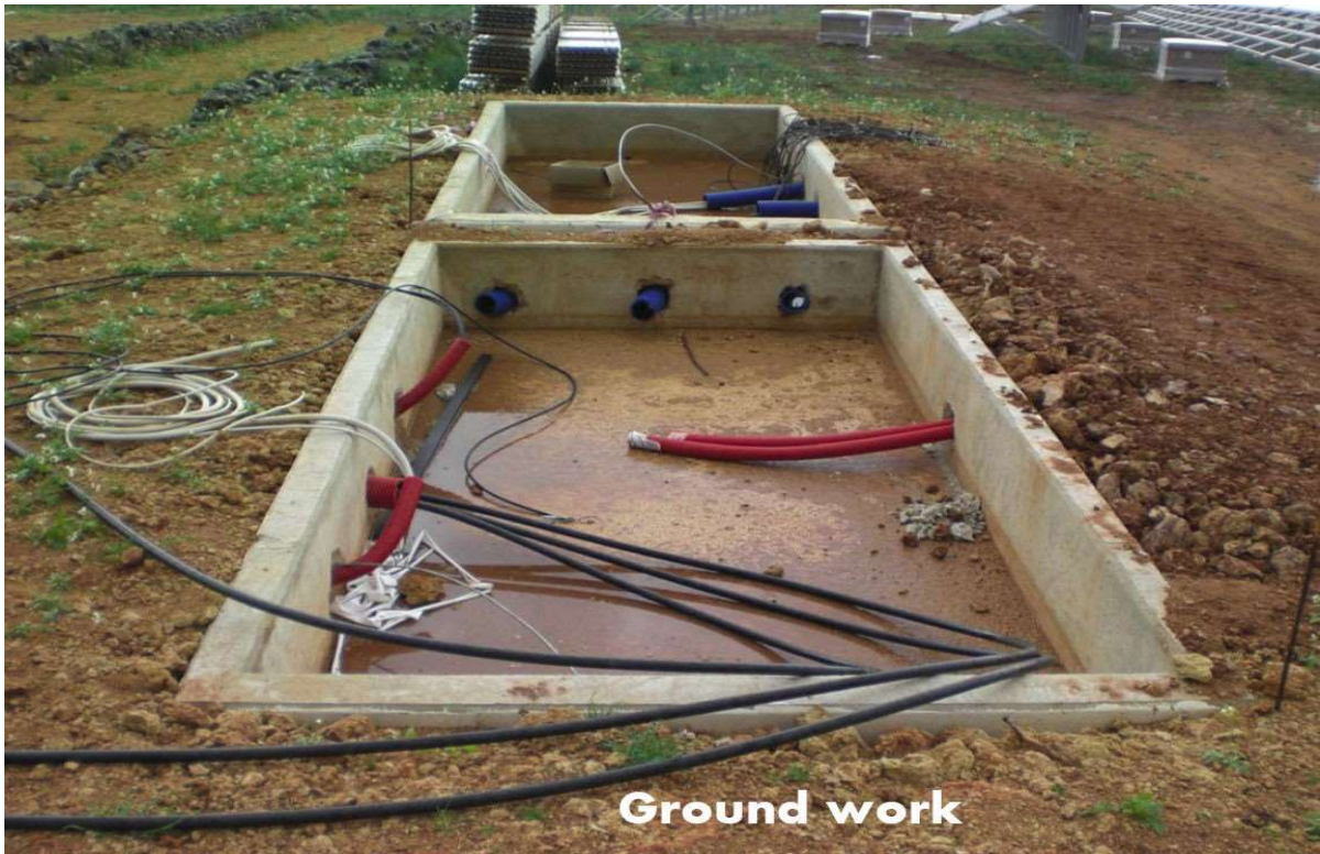
Figura 22 - Esempio basamento cabina
