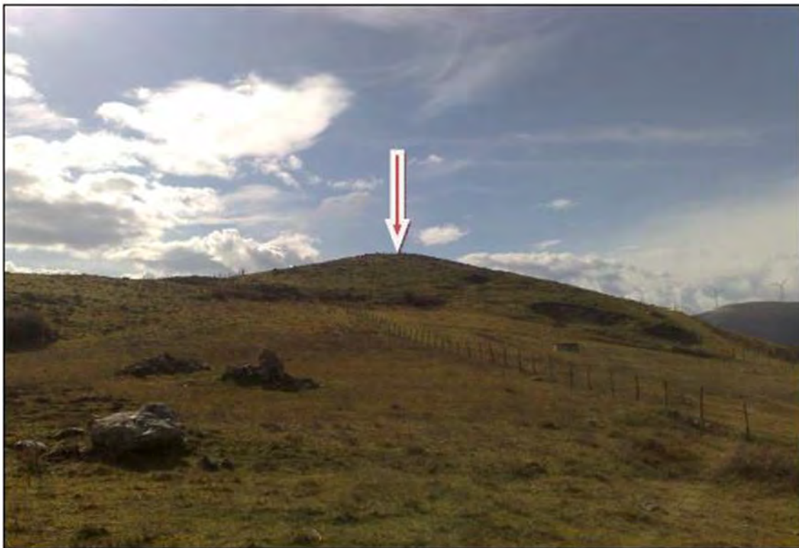
Fig.A20 _ SIA 2011: località Monte Salitto, viste delle posizioni della turbine 22 e 23
