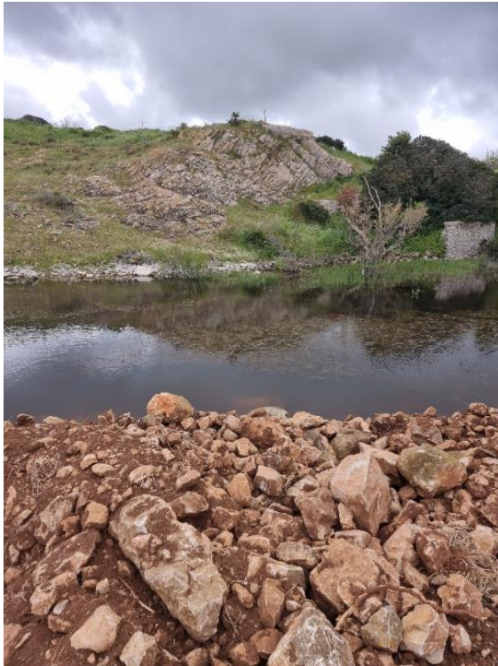
Scavi presso rilievo fattoria. L'impaludamento è probabilmente connesso a roccia subaffiorante
