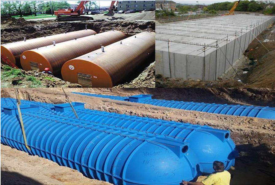
Figura 7: Opzioni di stoccaggio dell'acqua sotterraneo
