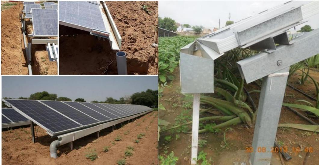
Figura 1: Impianto fotovoltaico a terra con grondaia integrata per la raccolta dell'acqua piovana
