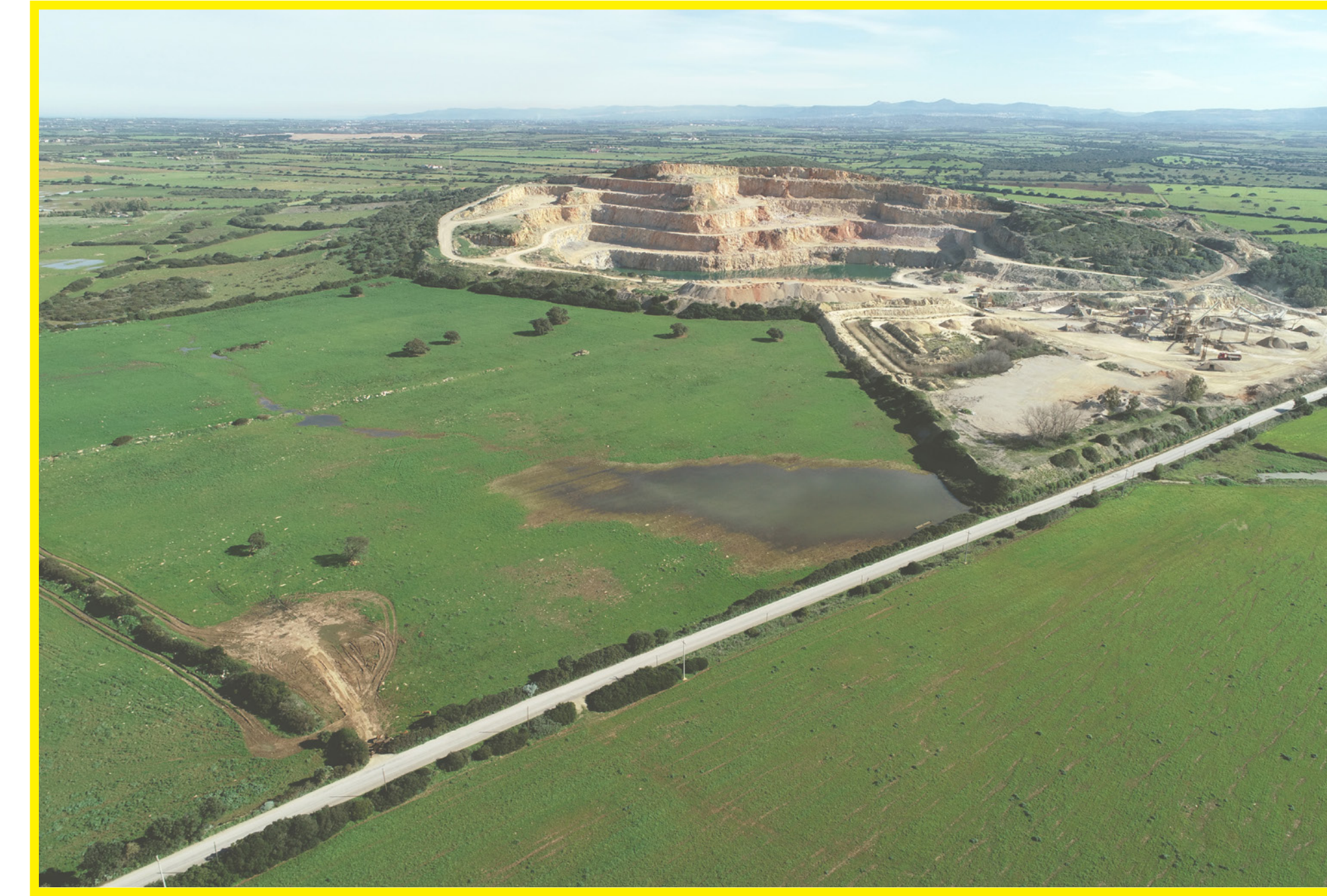
VISTA DA OVEST > EST Dettaglio Cava M. Nurra
