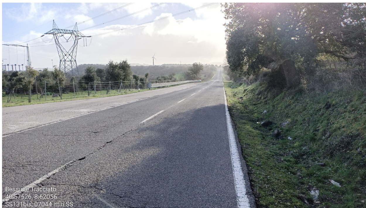
Ittiri, loc. Frades Isticas: Strada Statale 131 bis interessata dal cavidotto in progetto.
