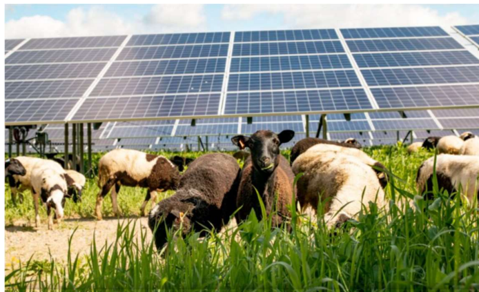
Figura 1.4: - Impianto agrovoltaico e pascolo ovini
