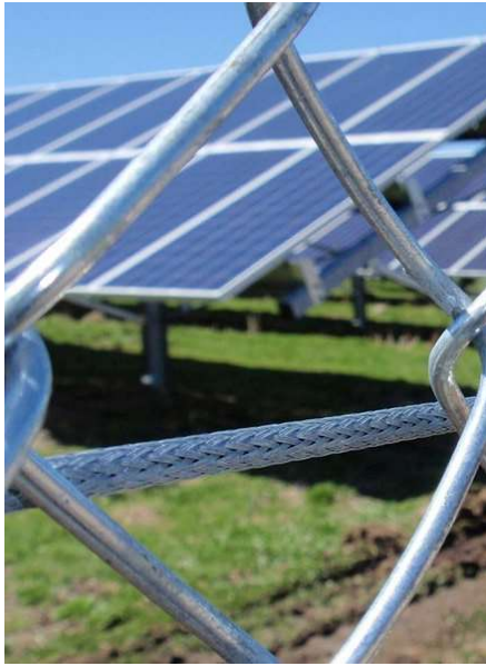
Figura 4.7 - Cavo in fibra ottica montato su rete metallica.
