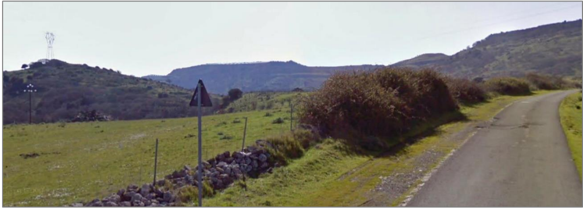
Figura 4.58: Vista da punto panoramico 1 – Progetto - L’impianto è leggermente visibile, pertanto l’impatto visivo-percettivo è scarso
