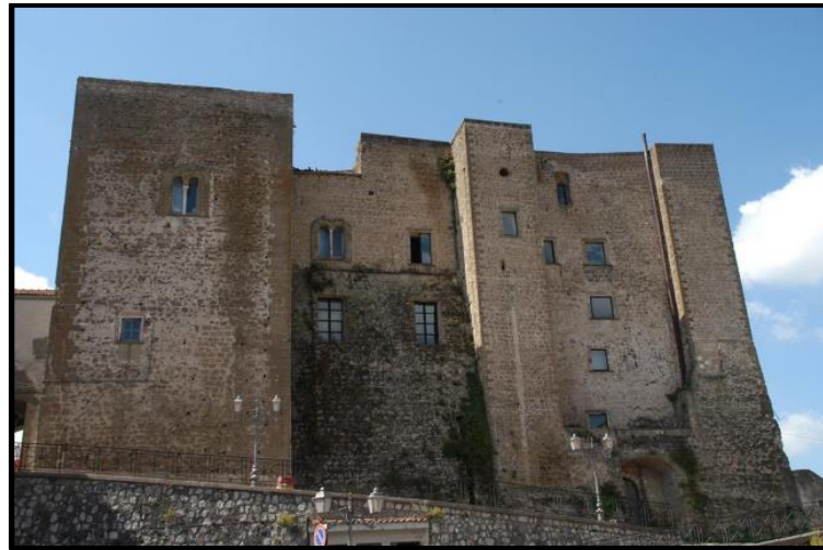
Fig. 33 - Facciata esterna del Castello ducale
