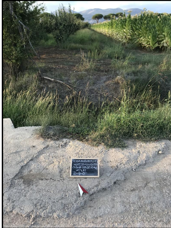
Fig. 63 - Immagine dell'area di ingresso del cavidotto alla Cabina di Trasformazione MT/AT
