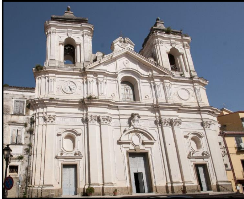
Fig. 36- Facciata esterna della chiesa dell’Annunziata.
