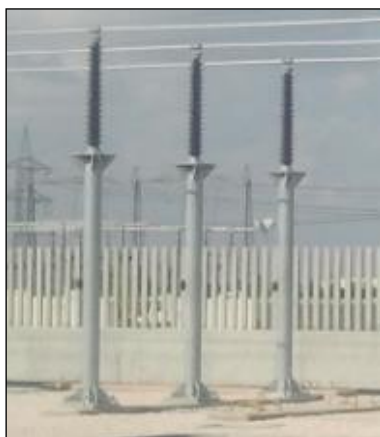
Fig. 17. Particolare in foto di tali supporti
