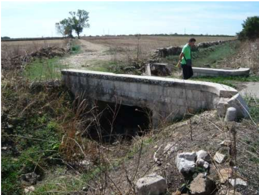
Foto 6.7 – Vista del ponticello presente nei pressi della sezione 9 del Reticolo A , il manufatto è realizzato in muratura e calcestruzzo.
