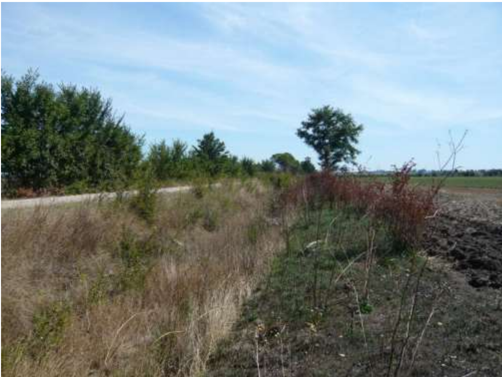
Foto 6.9 – Vista del canale a valle della sezione 2 del Reticolo A , in canale in questo tratto si presenta pieno di erbe infestanti.
