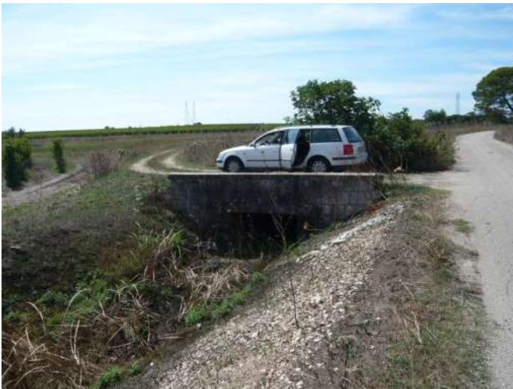
Foto 6.5 – Vista del ponticello realizzato in muratura e calcestruzzo nei pressi della sezione 14 del Reticolo A .
