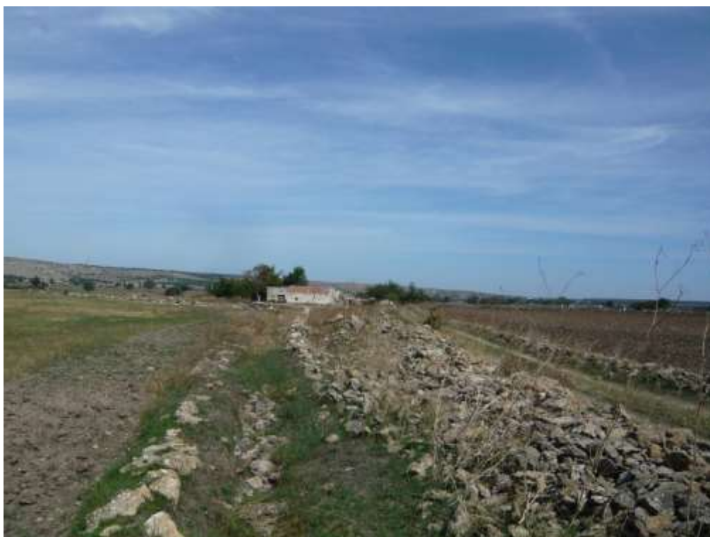
Foto 6.10 – Vista del canale a monte della sezione 21 del Reticolo B , il canale anche in questo tratto si presenta confinato dalla presenza di un muro a secco diruto.
