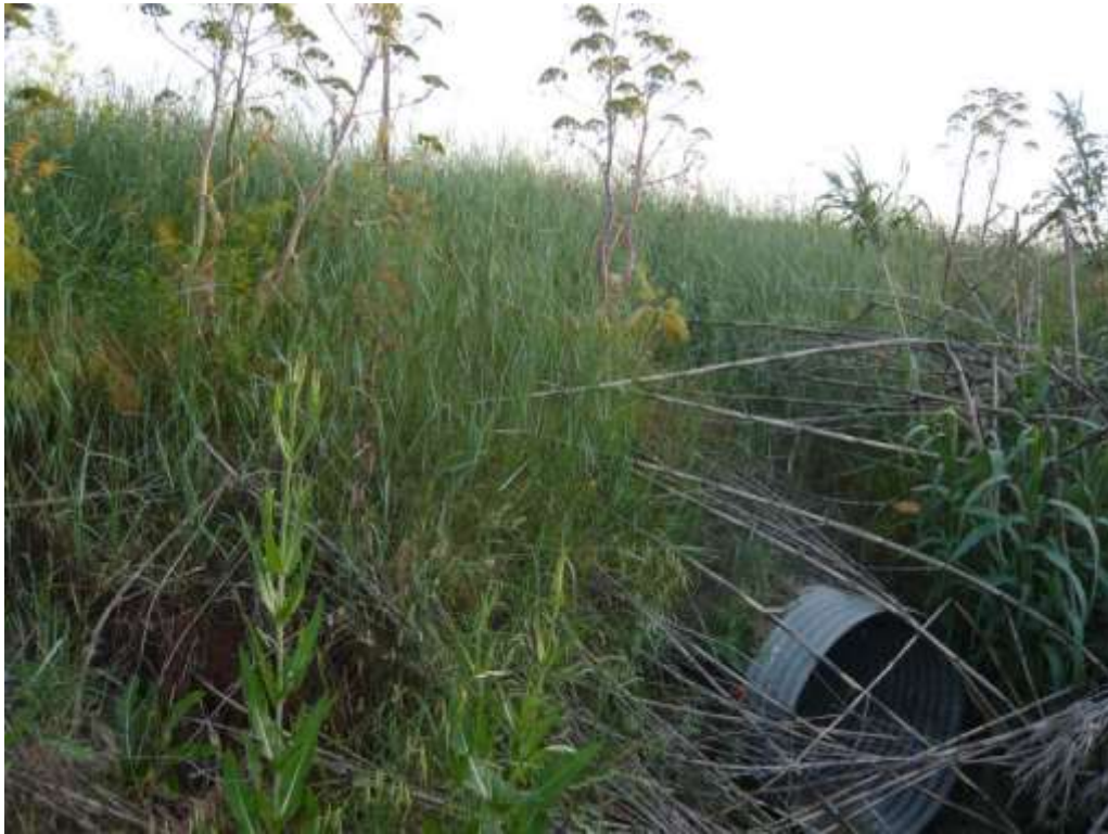
Foto 6.1 – Vista della parte alta del bacino, nei pressi della sezione 43 del Reticolo A1 , si può notare il tombino che attraversa il rilevato stradale.
