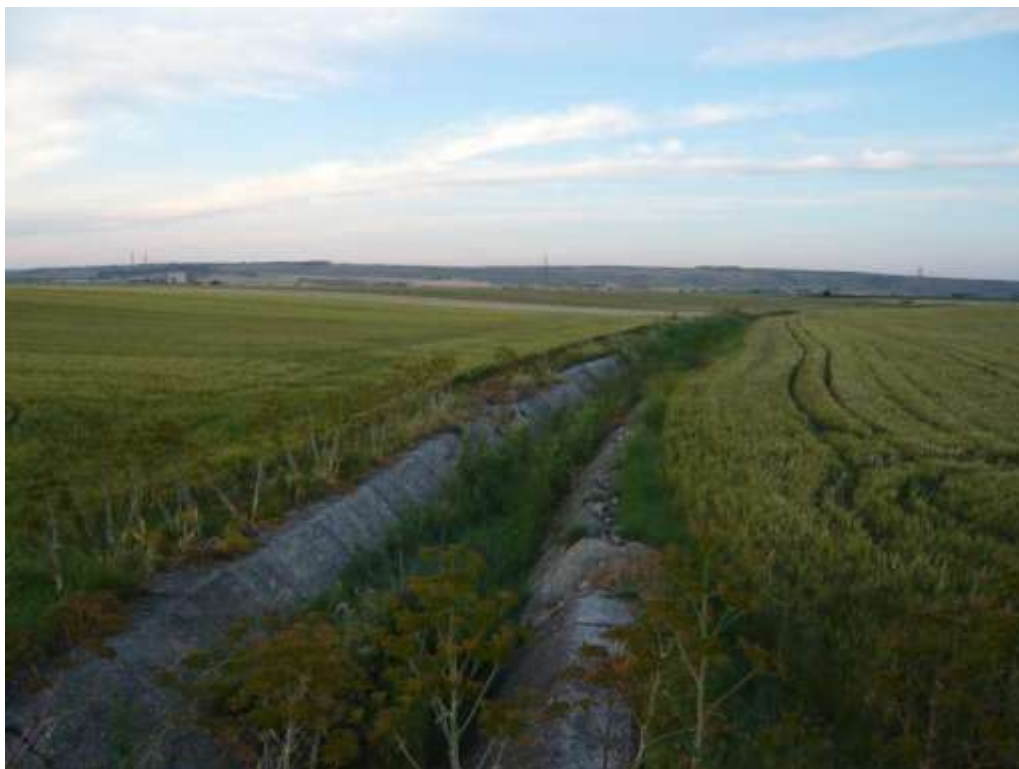
Foto 6.5 – Vista del canale in cls a valle della sezione 52 del Reticolo D , si può notare sul fondo la presenza di erbe infestanti.
