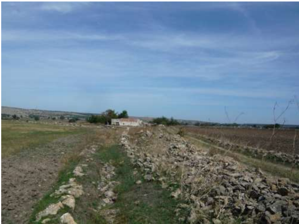
Foto 6.10 – Vista del canale a monte della sezione 21 del Reticolo B , il canale anche in questo tratto si presenta confinato dalla presenza di un muro a secco diruto.
