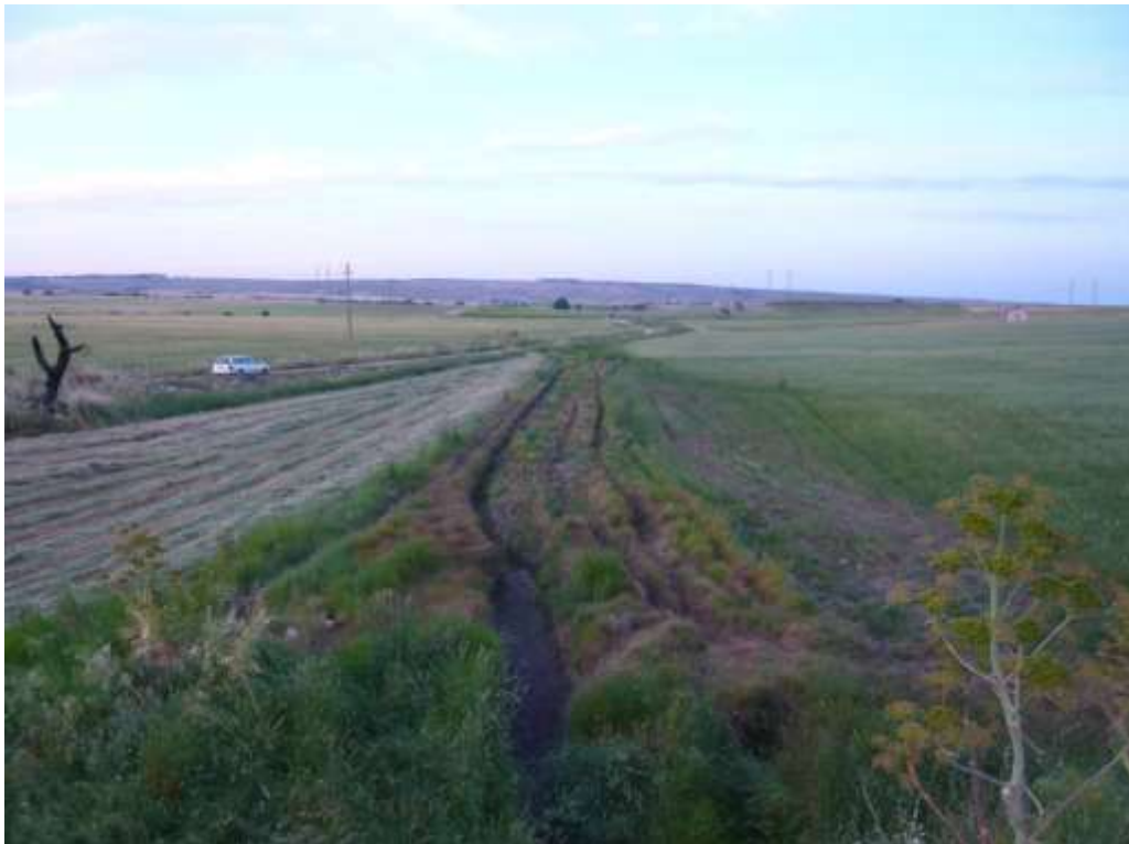
Foto 6.8 – Vista del canale in terra nei pressi della sezione 62 del Reticolo E .
