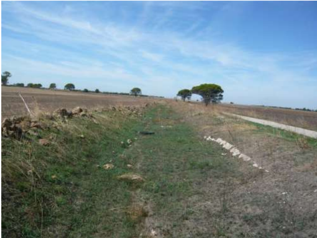
Foto 6.8 – Vista del canale a valle della sezione 5.1 del Reticolo A , si può notare sul fondo la presenza di depositi terrosi, in questo tratto il corso d'acqua rallenta.
