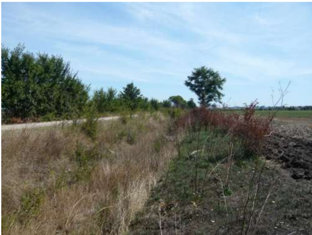
Foto 6.9 – Vista del canale a valle della sezione 2 del Reticolo A , in canale in questo tratto si presenta pieno di erbe infestanti.
