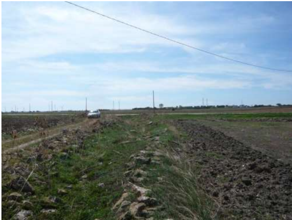
Foto 6.10 – Vista del canale a monte della sezione 23 del Reticolo B , il canale in questo tratto si presenta confinato dalla presenza di muri a secco diruti.
