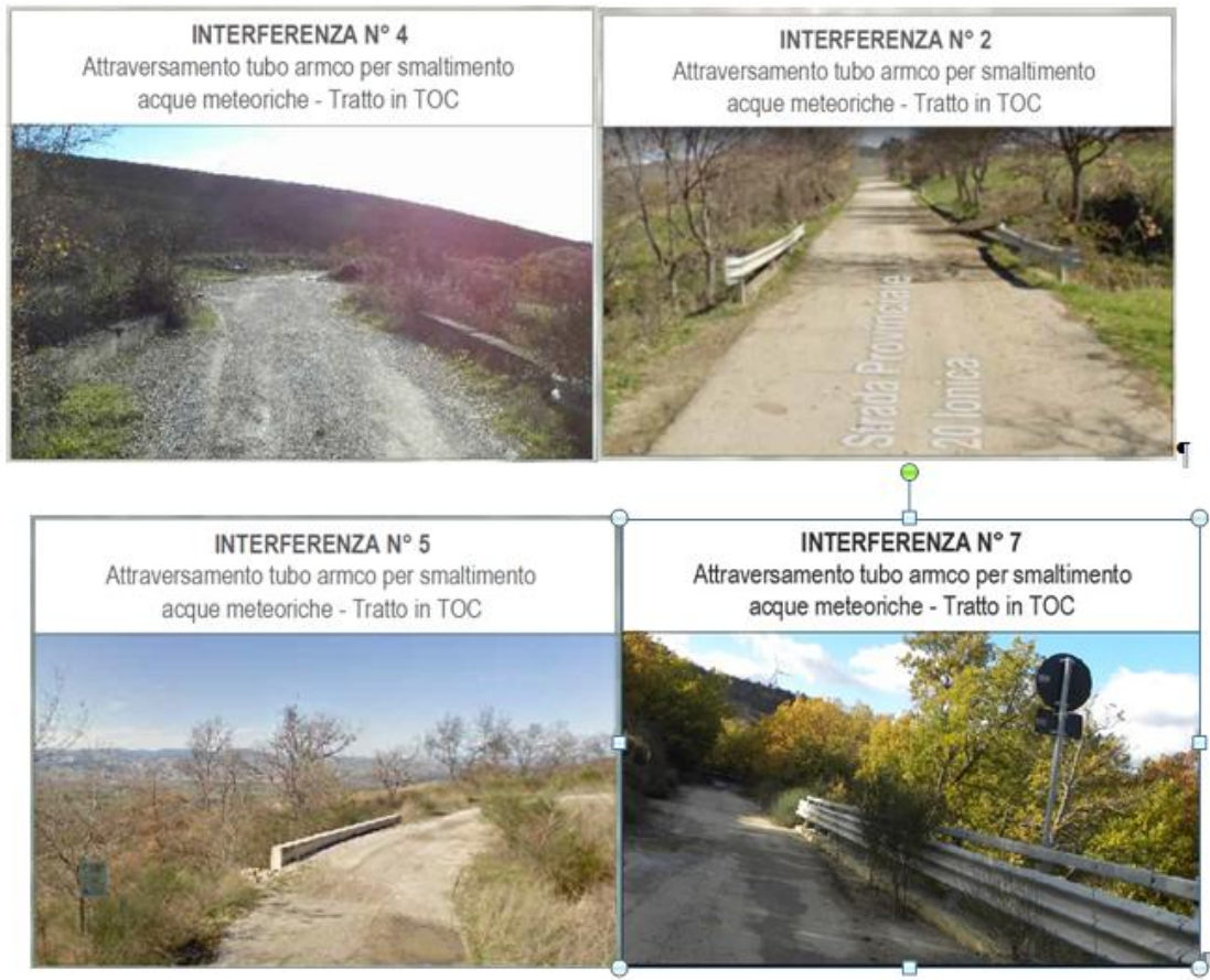
Figura 45: Interferenze con i tubi Armco
