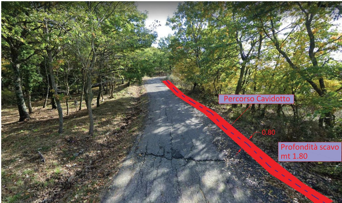
Figura 49: Ripresa fotografica del percorso del cavidotto di connessione in fregio alla viabilità esistente
