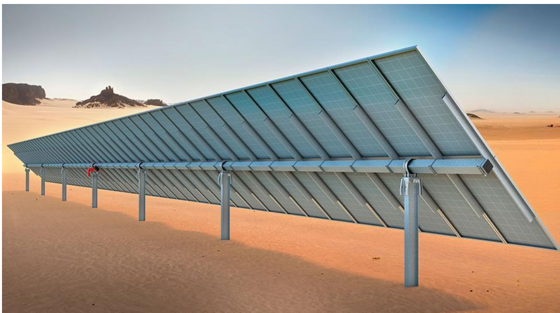
Figura 8: Immagine qualitativa della struttura di supporto
