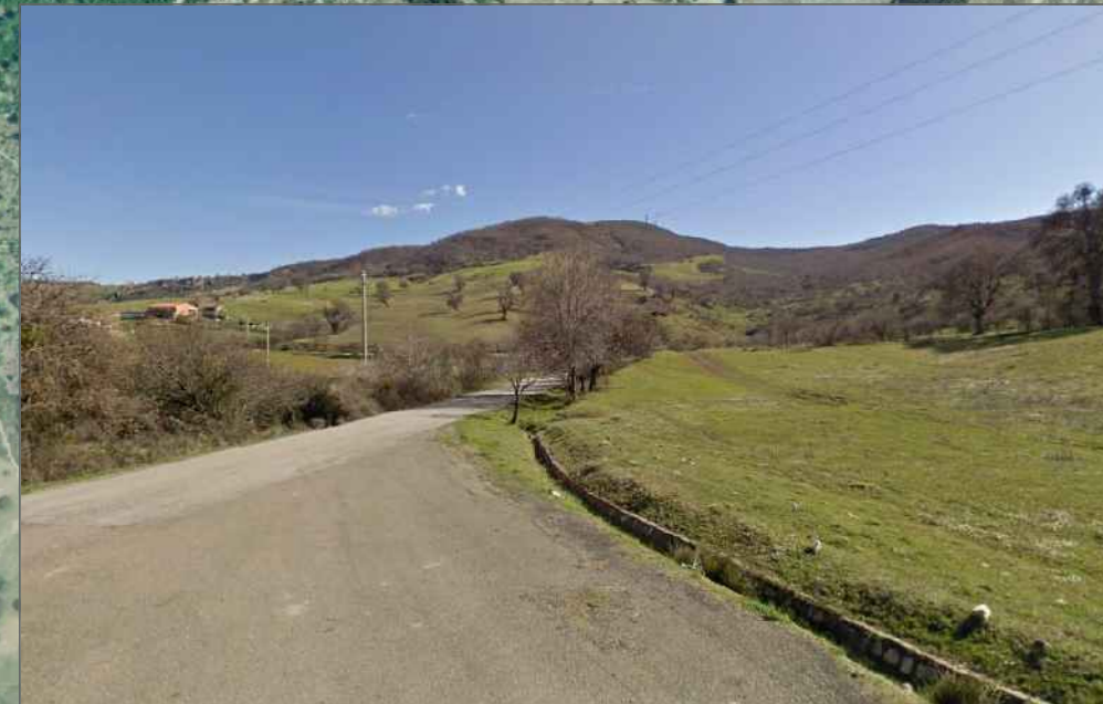
15. Vista dalla Strada Provinciale 20 Ionica (5,8 Km dalla nuova stazione SE)
