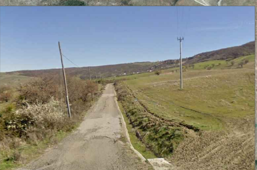
14. Vista dalla Strada Provinciale 20 Ionica (6,5 Km dalla nuova stazione SE)
