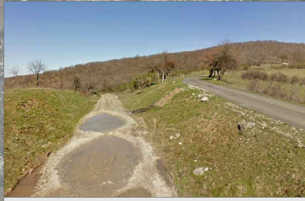
6. Vista dalla Strada Provinciale 20 Ionica (2,9 Km dalla nuova stazione SE)
