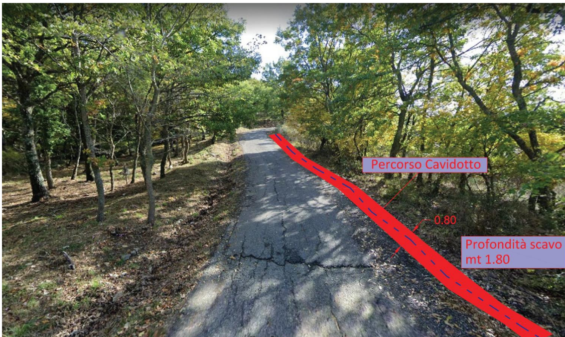
Figura 46: Ripresa fotografica del percorso del cavidotto di connessione in fregio alla viabilità esistente
