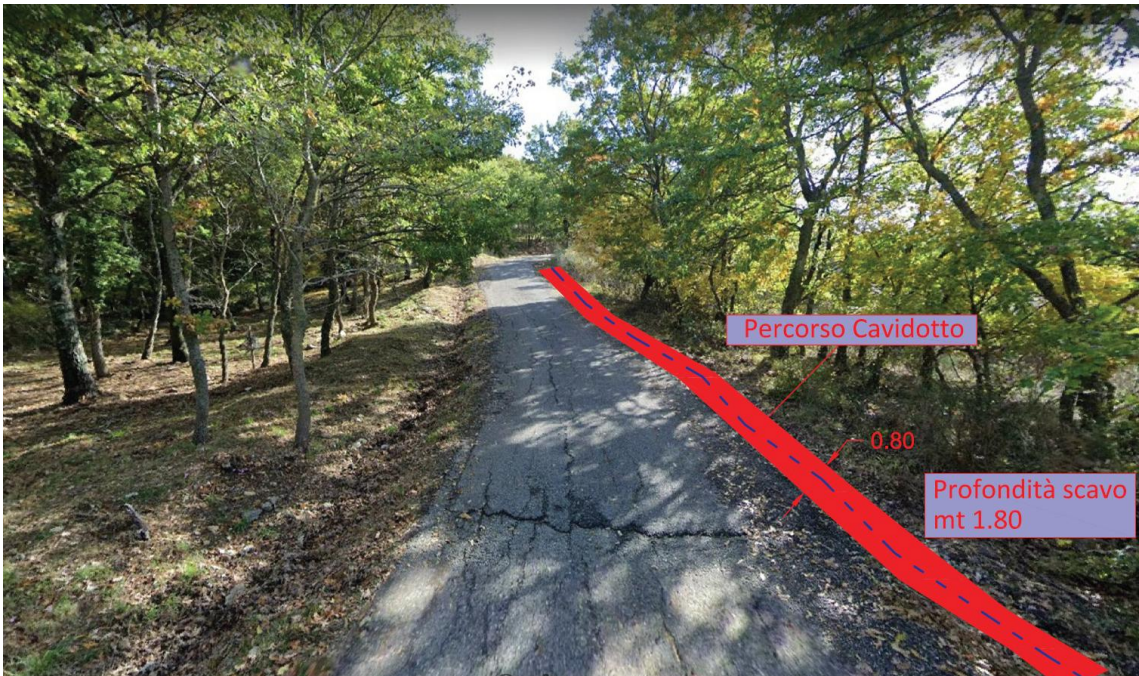
Figura 43: Ripresa fotografica del percorso del cavidotto di connessione in fregio alla viabilità esistente
