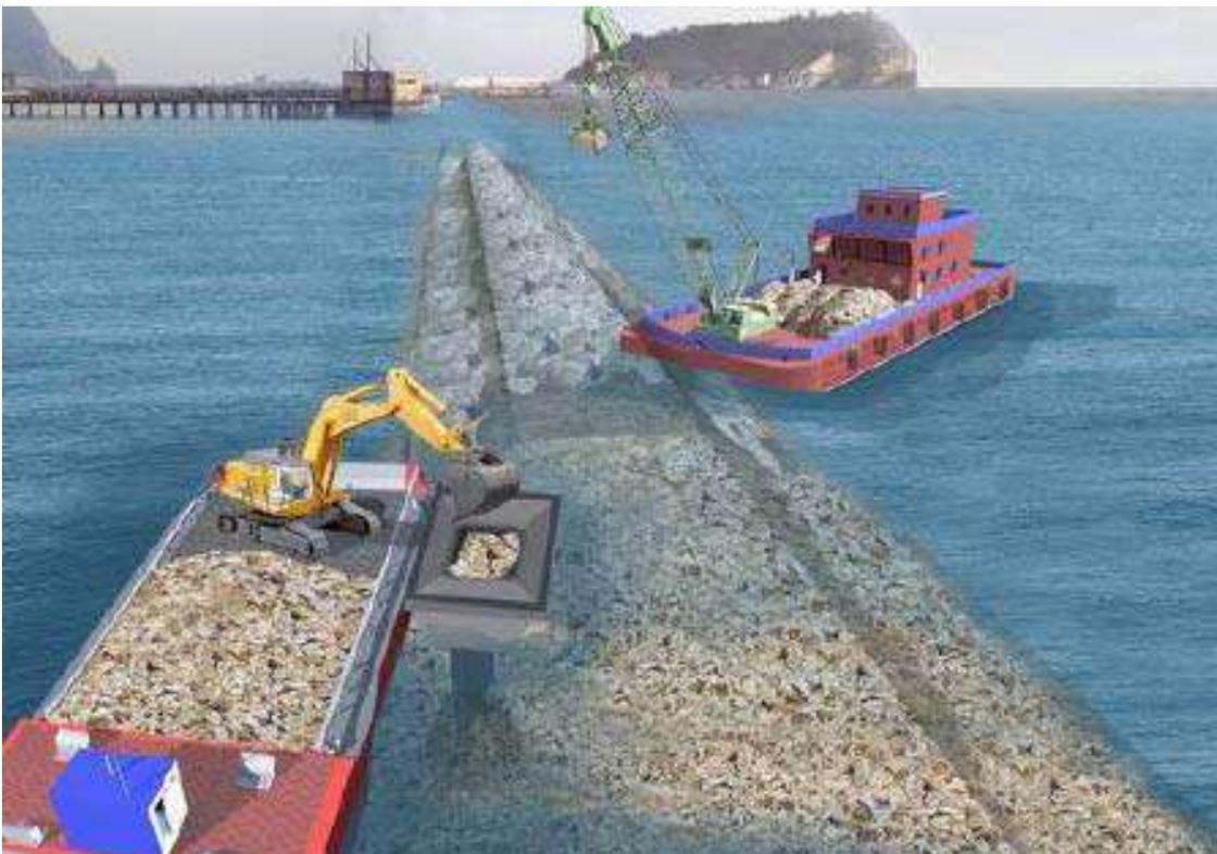
**Figura 3-29 Esempio di fase di posa del nucleo e del mantello della soffolta con i dispositivi antitorbidità che evitano l'attraversamento della colonna d'acqua.**
