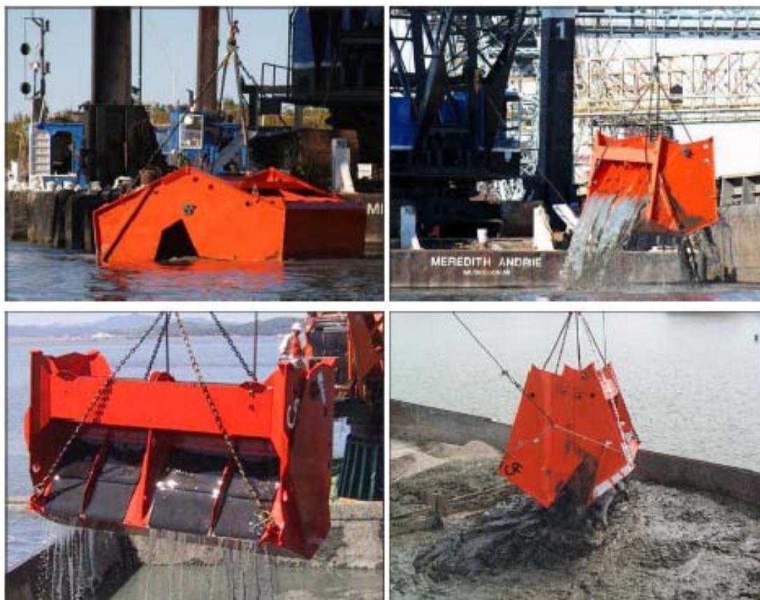
Figura 2-1 Benna ecologica: foto di cantiere.
