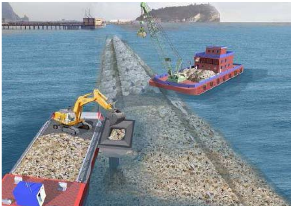
Figura 2-2 Esempio di fase di posa del nucleo e del mantello della soffolta con i dispositivi antitorbidità che evitano l'attraversamento della colonna d'acqua.
