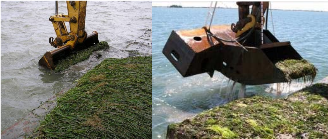
Figura 3-18 Fase di prelievo di grandi zolla mediante mezzi meccanici, con benna tradizionale (a sinistra) e con benna idraulica (a destra) recentemente messa a punto che permette di realizzare lo scavo per alloggiamento delle zolle contestualmente alla posa.
