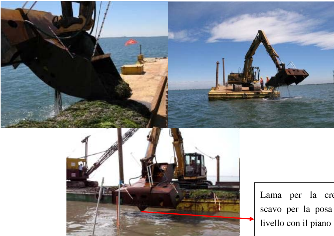
Figura 3-21 Benna idraulica appositamente realizzata per il prelievo di grandi zolle.
