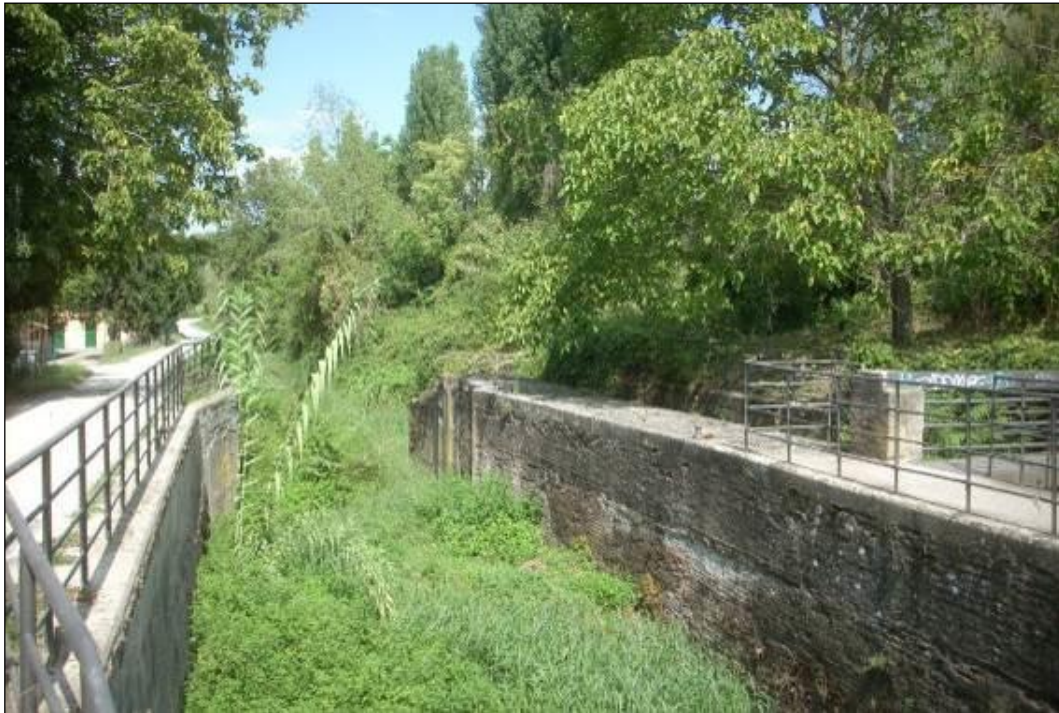
Figura 5-36 – Alveo artificiale Canale Navile, particolare delle opere idrauliche e dei rivestimenti delle sponde.
