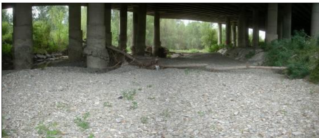
Figura 5-26 - Alveo del F. Reno panoramica verso monte (foto 2016): depositi alluvionali recenti con uno spessore 1 \pm 1.5 m; si notano porzioni residuali relative alle opere di protezione sui plinti del sistema tangenziale in esercizio.
