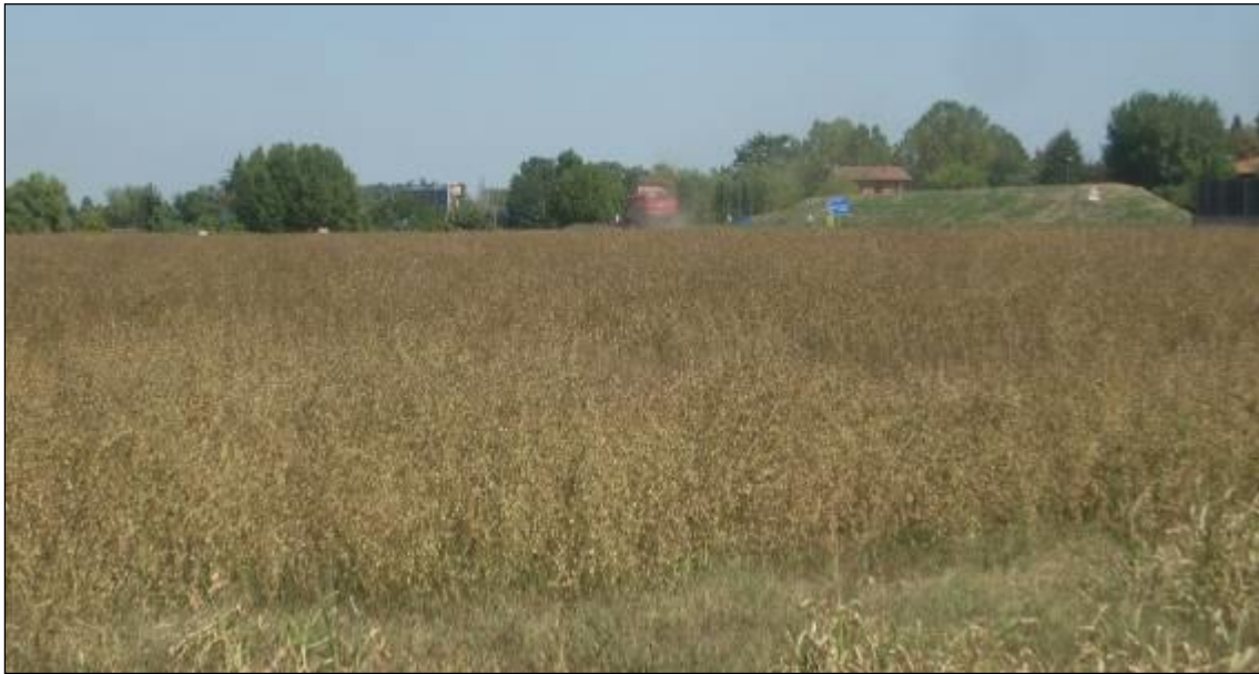
Figura 5-44 – Rilevato artificiale in località Case Alte, con altezza variabile da 3-5 m con funzione di mitigazione acustica.
