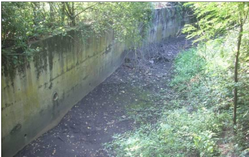
Figura 5-32 - Alveo attuale del Savena Abbandonato, si noti la risagomatura artificiale delle sponde.
