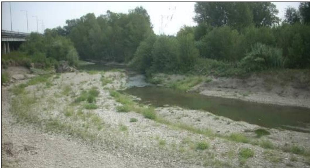
Figura 5-22 - Alveo attuale del F. Reno: a sinistra della foto (2016) si individuano depositi alluvionali recenti con uno spessore variabile in 1÷1.5 m.
