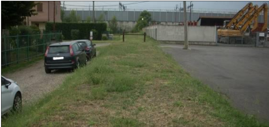
Figura 5-13 - Argine artificiale del F. Reno in loc. Bonora; in secondo piano l'impalcato della Tangenziale.
