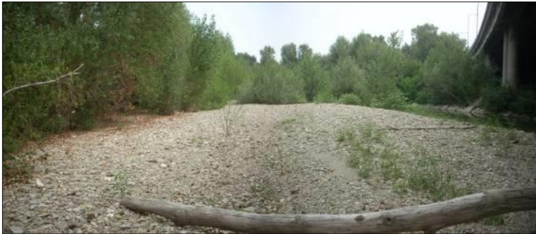
Figura 5-23 - Alveo attuale del F. Reno (foto 2016): sono presenti depositi alluvionali recenti con spessore variabile 1÷1.5 m.
