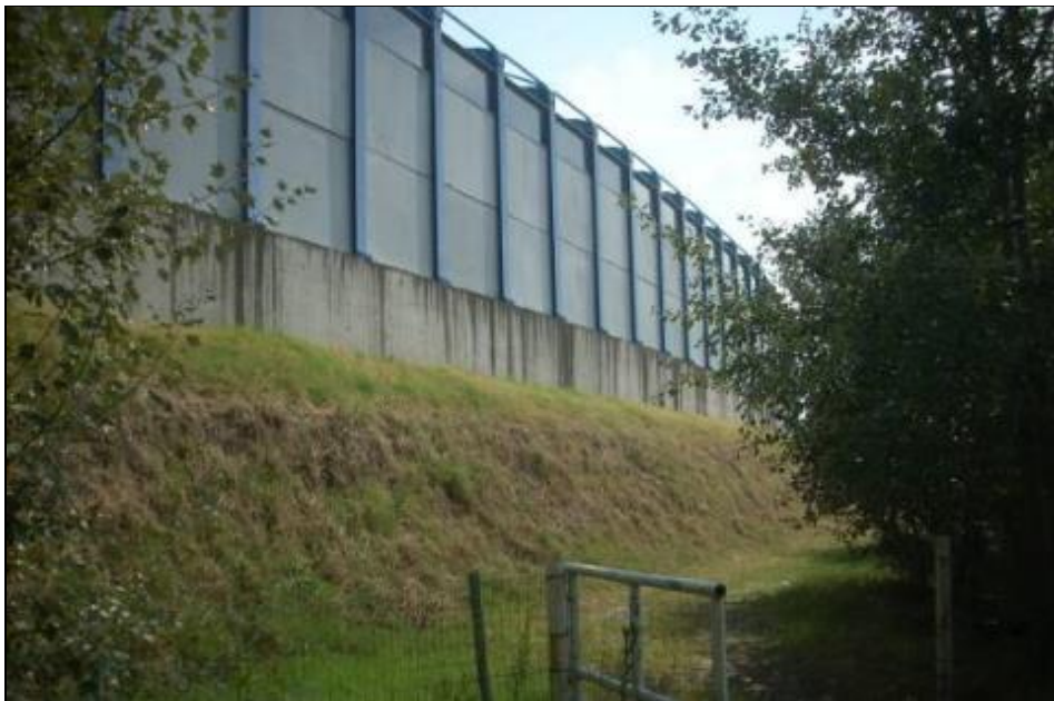
Figura 5-38 – Rilevato artificiale, in via del Saliceto con altezza media da 2÷3 m circa con funzione portante del muro di contenimento del sistema tangenziale in esercizio.
