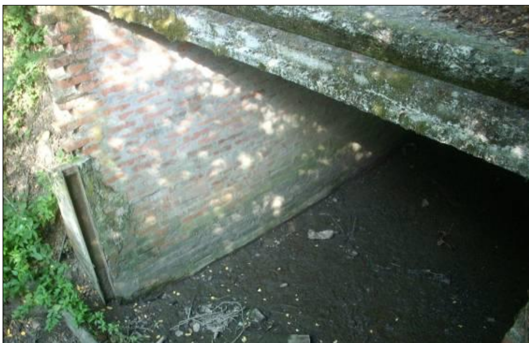
Figura 5-33 - Alveo Savena Abbandonato, si noti lo scatolare in muratura per l'attraversamento.
