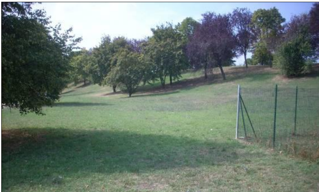
Figura 5-35 – Rilevato artificiale nei pressi dello svincolo di immissione su A13, altezza media da 2÷4 m circa con probabile funzione di mitigazione acustica e sede di cavidotto industriale.
