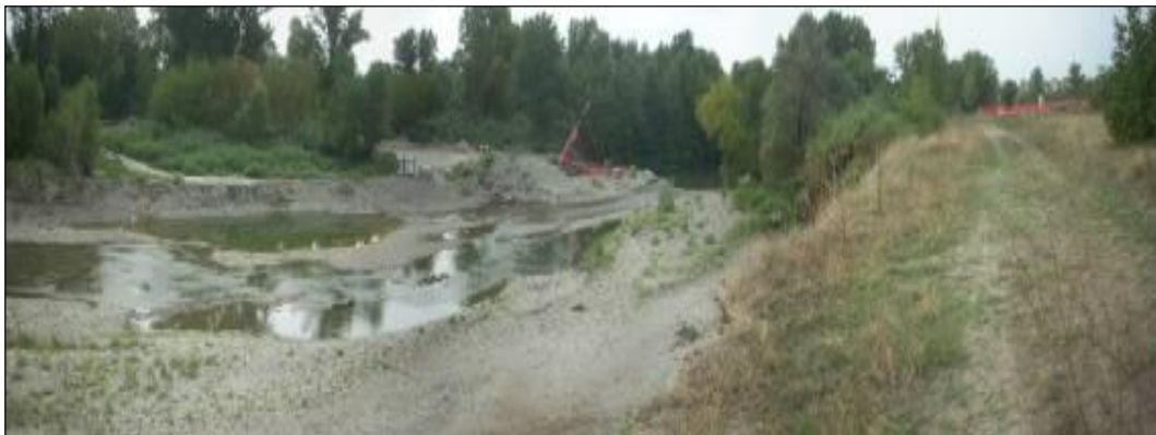
Figura 5-19 – Alveo attuale del F. Reno (foto panoramica del 2016 verso monte): a destra le scarpate fluviali di altezza variabile da 3÷4 m; in secondo piano attività di movimento terra inerente alla costruzione del nuovo viadotto ferroviario – People Mover.
