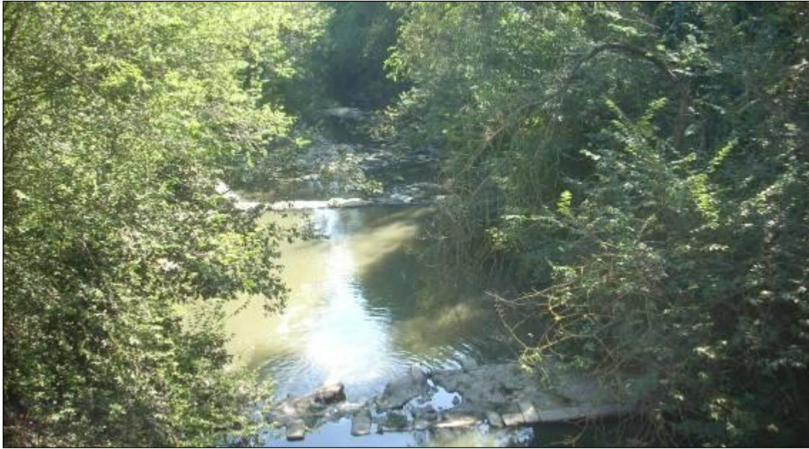
Figura 5-42 - Alveo del T. Savena: depositi alluvionali recenti, spessore medio di 1 m; si individua il profilo di due briglie fluviali dotate di scarsa manutenzione (località Caselle).
