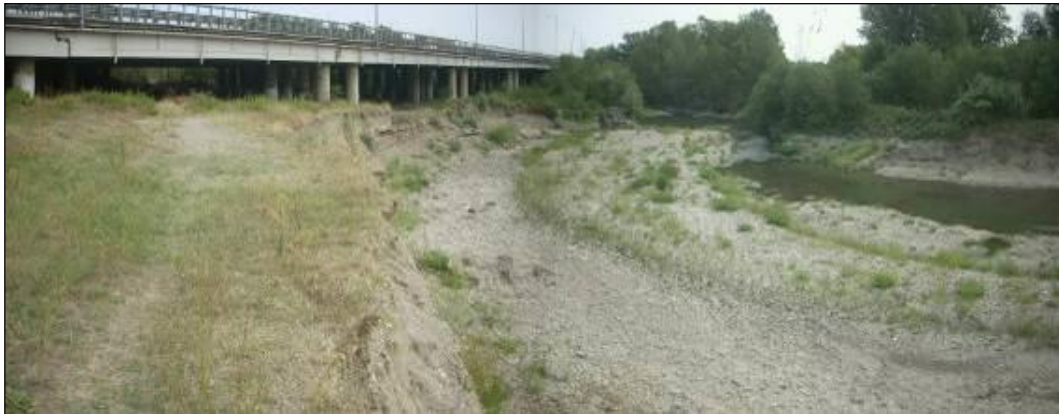
Figura 5-18 – Alveo attuale del F. Reno (panoramica verso valle del 2016): a sinistra scarpate fluviali di altezza variabile da 3÷5 m; in secondo piano l'impalcato del sistema tangenziale in esercizio.
