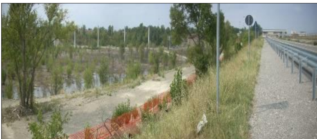
Figura 5-15 - Morfologia depressa di origine antropica derivante dalle attività estrattive, attualmente occupata da ristagni d'acqua e da un viadotto ferroviario in costruzione (People Mover, in foto pali verticali bianchi nel 2016), a sud-ovest dell'aeroporto di Bologna.
