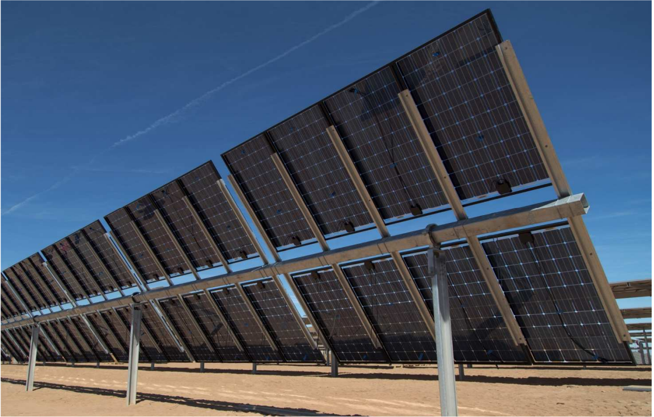
Figura 7-5: Esempio struttura e modulo FV bifacciale
