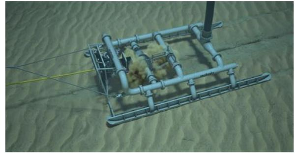
**Figura 6.11 – Protezione del cavidotto marino all'interno di una trincea.**
