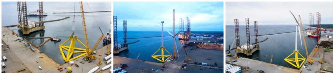
**Figura 7.2 – Sollevamento ed installazione della turbina eolica.**
