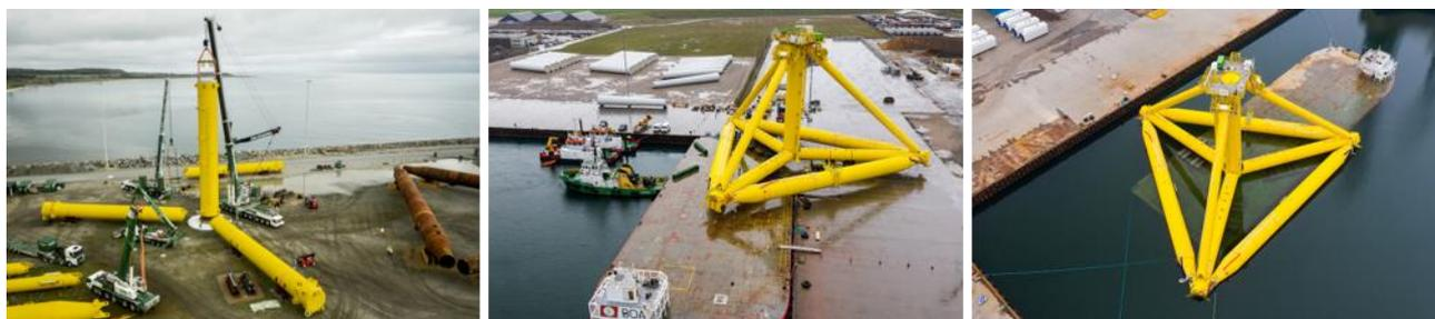
**Figura 7.1 – Assemblaggio e varo della fondazione galleggiante.**
