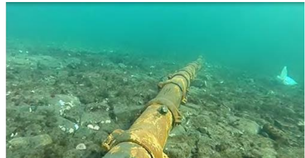
Figura 4.16 – Protezione del cavidotto marino mediante gusci in ghisa.
