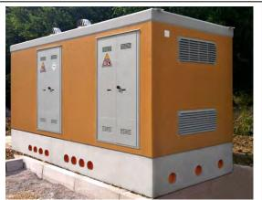
Di seguito la vista della struttura di copertura del basamento, su cui alloggiare il container con le apprecchiature o la cabina prefabbricata:
