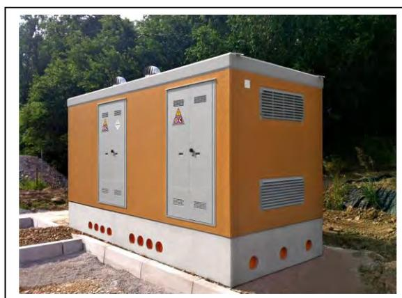
Tali cabine prefabricate o box, saranno posizionati su apposite platee predisposte nei punti indicati in planimetria. Ciascuna platea sarà realizzata per contenere tutti i cavidotti di collegamento all'impianto e per cavidotto di consegna in MT.
