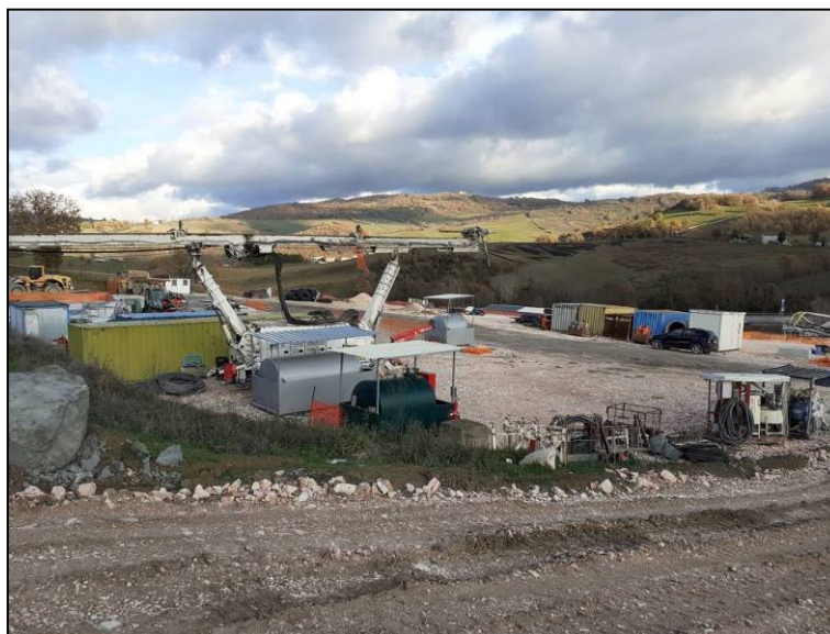
Particolare stazione di campionamento SUOLO_CB cantiere Base località Piano dell'Abate III C.O. dicembre 2021
