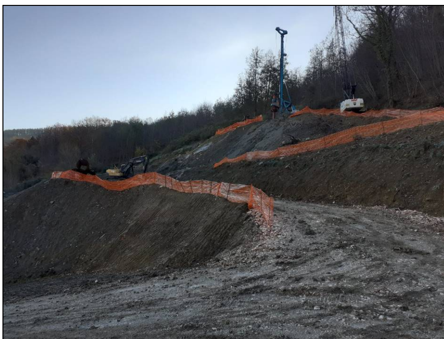
Area di cantiere imbocco lato Ancona Galleria Naturale "Picchiarella" Stazione di monitoraggio SUOLO_02 – III C.O. dicembre 2021
