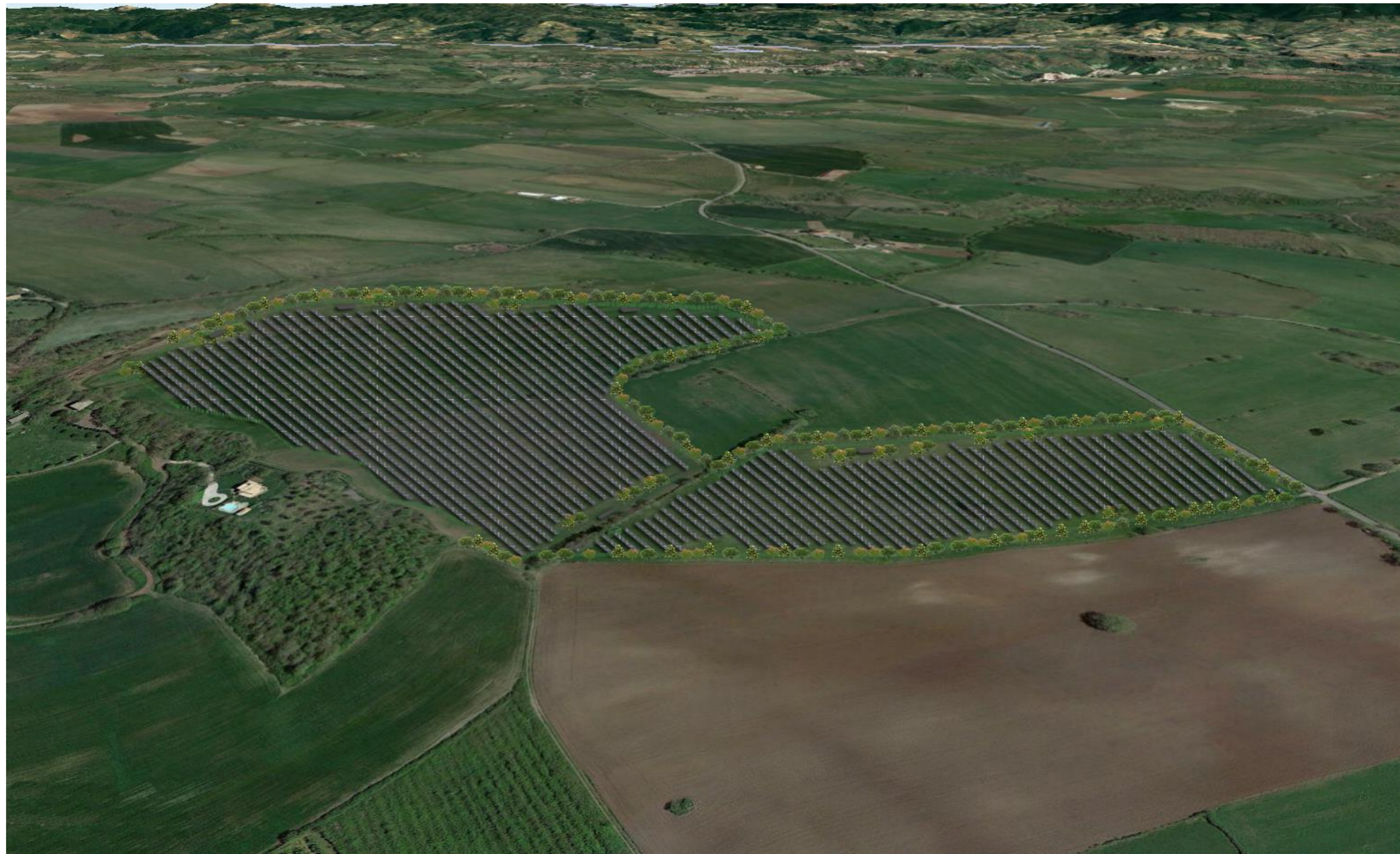
Figura 12 – punto di vista 5 – vista area impianto FV – loc. Falaschino
