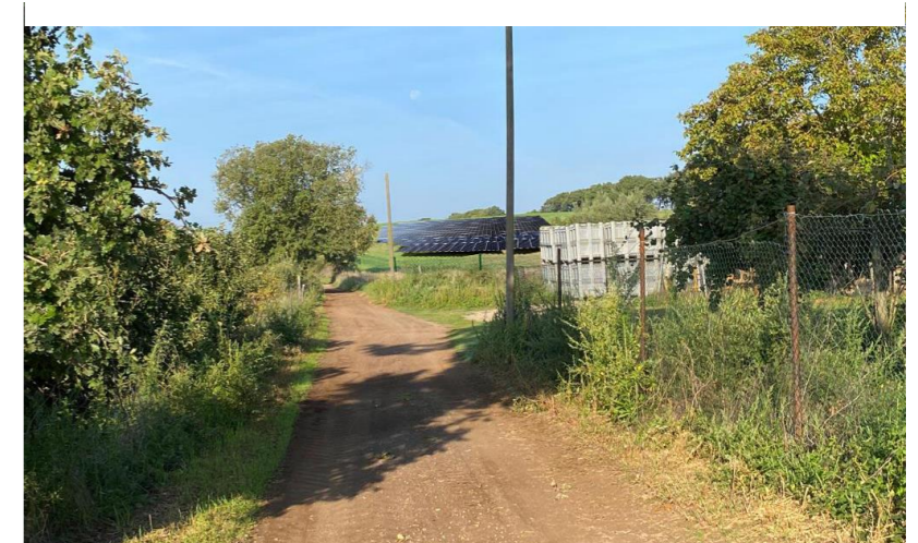
Figura 14 - punto di vista 1 - Area 2 - Loc. Costa Lombarda - post operam senza mitigazione
