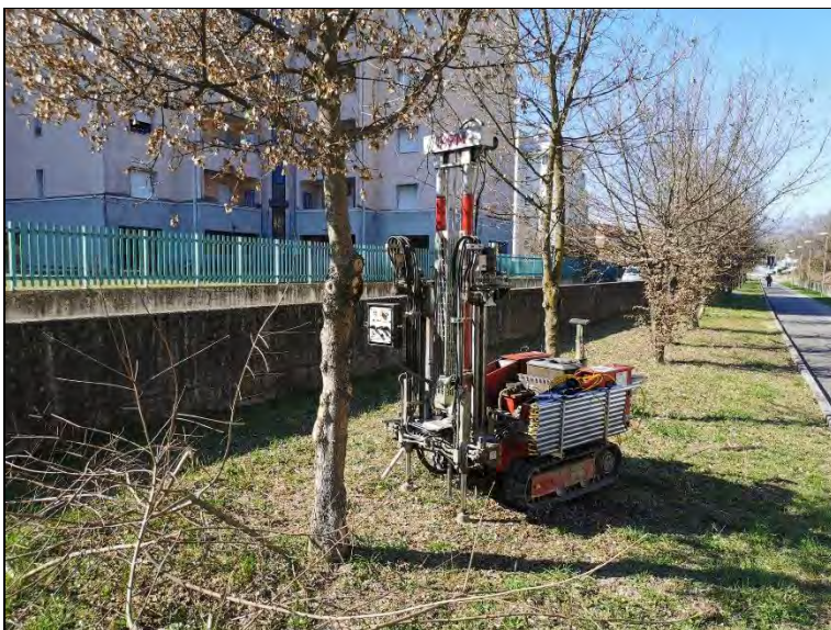
Esecuzione prova DPSH3
