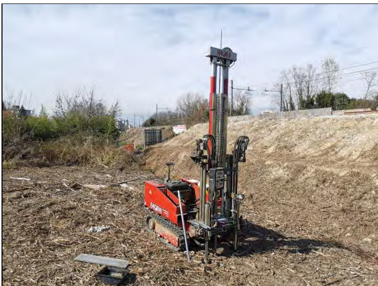
Esecuzione prova DPSH6
