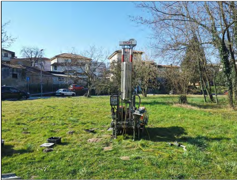
Esecuzione prova CPTU1 (preforo DPSH1)
