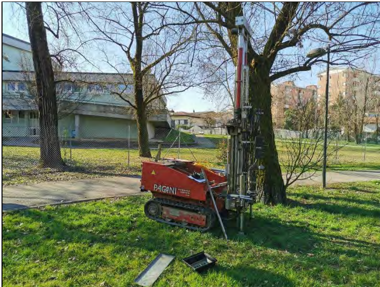
Esecuzione prova DPSH4
