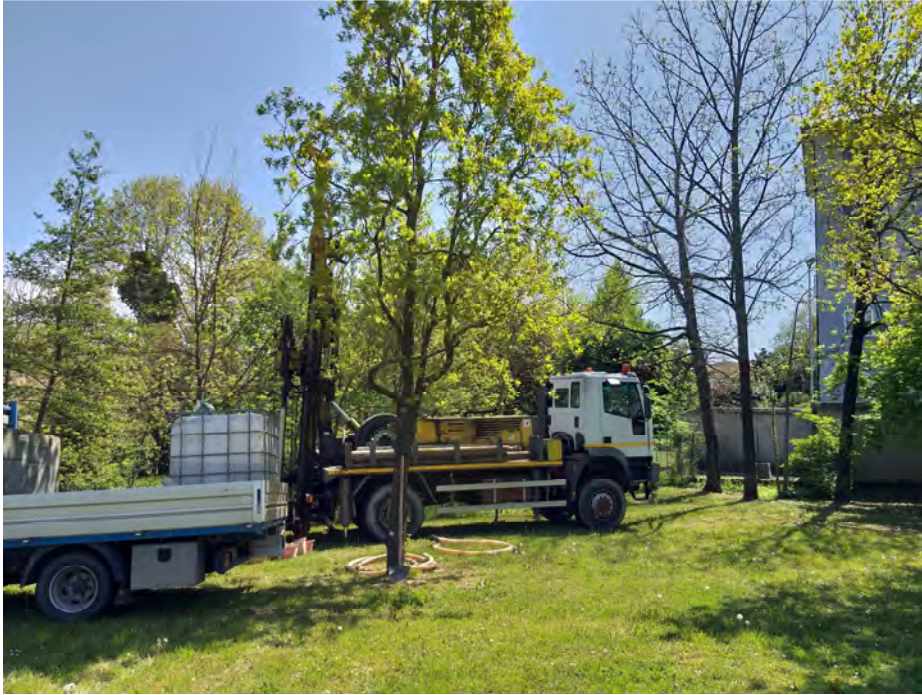
Sondaggio S4, postazione delle attrezzature
