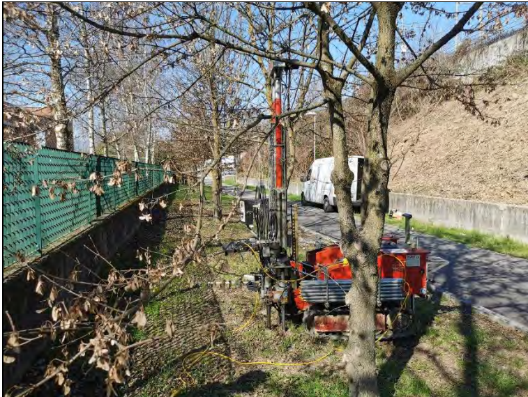
Esecuzione prova CPTU2 (preforo DPSH2)
