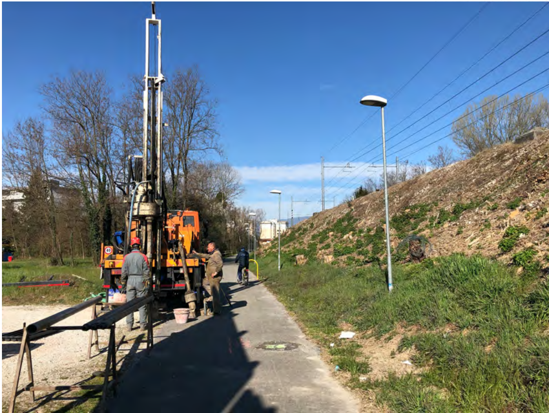
Sondaggio N° 2, postazione delle attrezzature
