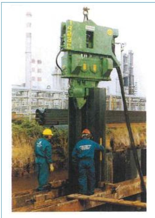
Fig. 20. Vibroinfissore ad alta frequenza
